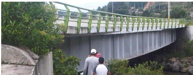
Fig. 2 Puente de Vigas
