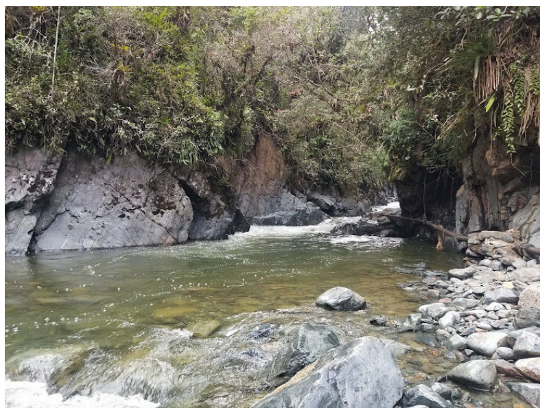
Figura 6 Ubicación de la captación en el río San Francisco
