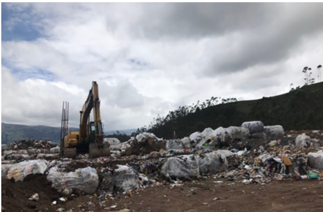
Ilustración 12. Equipos del Relleno Sanitario Yurak Kasha
