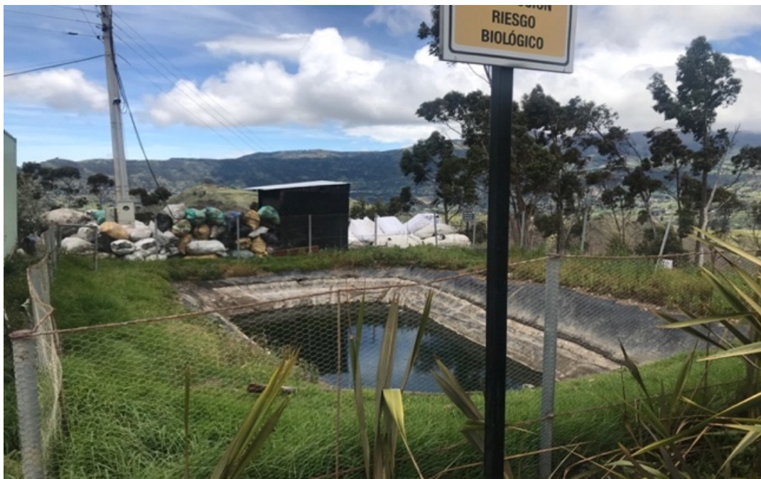
Ilustración 14. Piscina de Lixiviados del Relleno Yurak Kasha
