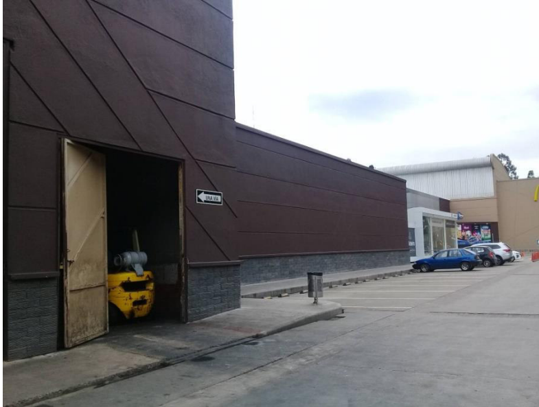
Ilustración 37: Vista exterior del lugar donde se almacena el contenedor para el almacenamiento de residuos sólidos en el centro comercial Mall del Río.
