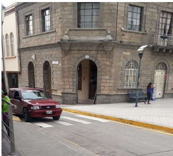
FIGURA 3.20: Barrera arquitectónica que impide el ingreso al Parque central de la ciudad de Azogues, Ecuador, 2020. Fuente: Mario León.
