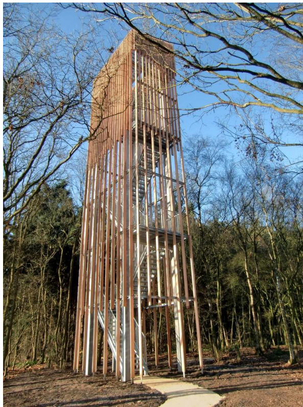
Ilustración 2. Torre de Avistamiento en Vecht Riverbank
