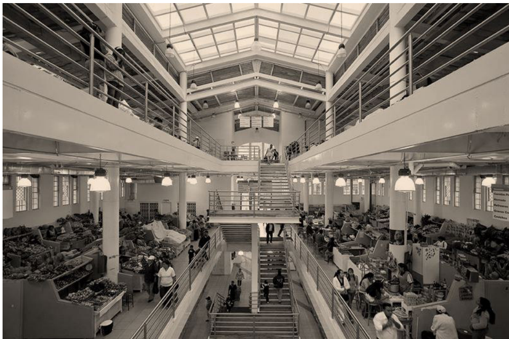
FIGURA 1.6: Mercado 9 de octubre regeneración interna. Fuente: propia
