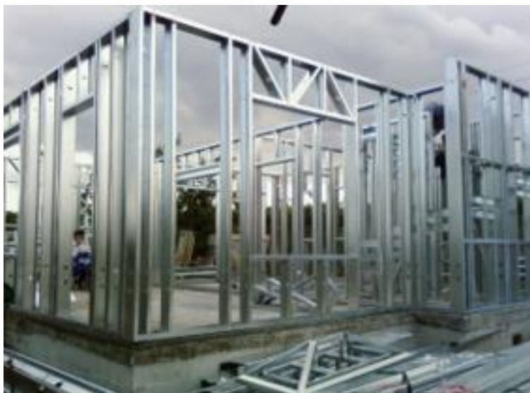
Figura 22: Estructura Steel Frame
