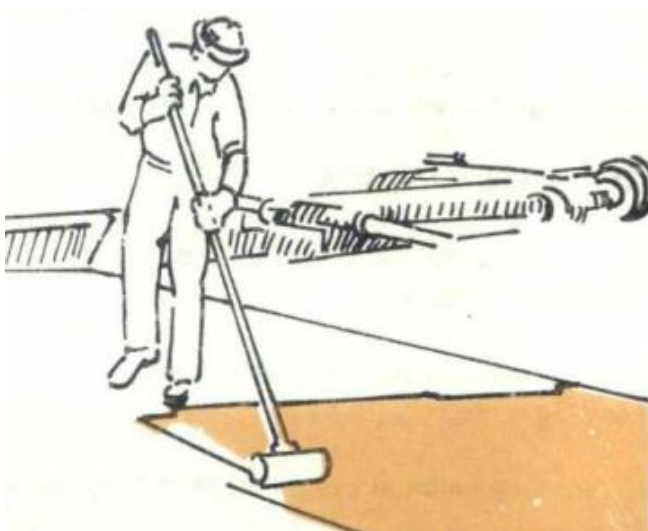
Figura 35: Colocación de Impermeabilizante acrílico en cubierta
