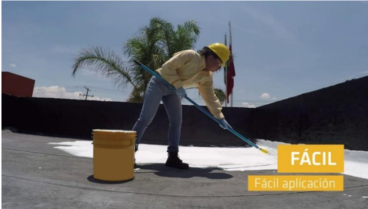
Figura 39: Aplicación de impermeabilizante Sikalastic-560
