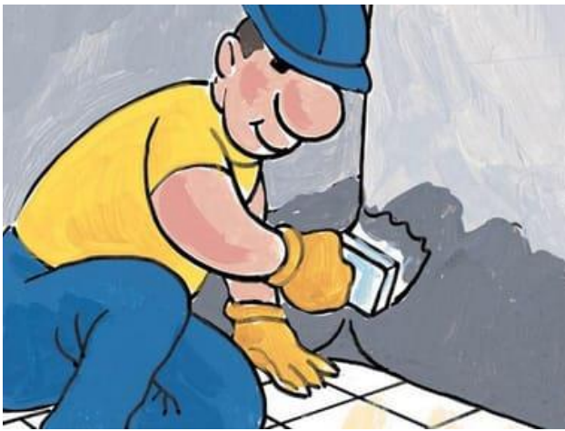
Figura 36: Aplicación del impermeabilizante cementoso con ayuda de brocha
