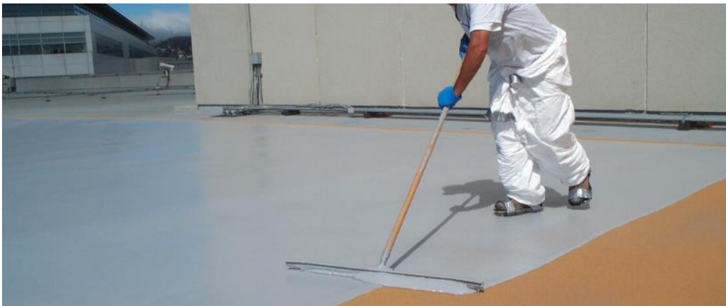
Figura 38: Impermeabilizante fibrado en azotea
