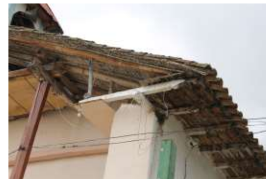
Fotografía N° 33: Vista de unión de los canecillos con la solera.
