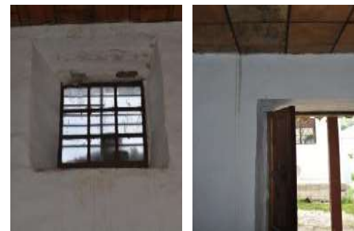
Fotografía N° 136-V8. 137-v9: Restauracion del Revoque.
