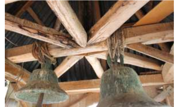
Fotografía N° 37 y 38: Vista del soporte del campanario.
