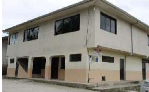
Fotografía N° 102, 103 y 104: Fachadas de Guardería Arco Iris.
