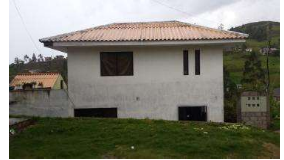
Fotografía N° 105, 106 y 107: Fachadas de vivienda colindante a la capilla.
