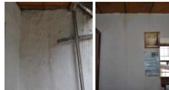
Fotografía N° 142-V10. 143-V12: Restauración del cielo raso y revoque.
