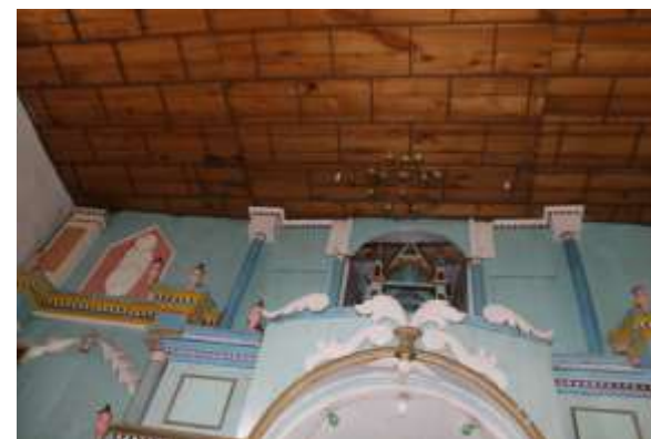
Fotografía N° 54: Vista del cielo raso – cubre parte superior del retablo.
