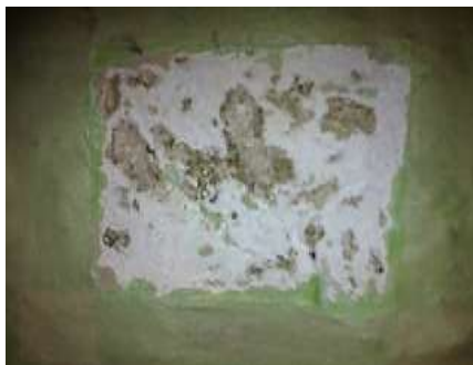
Fotografía N° 63, 64 y 65: Catas de la capa pictórica del zócalo de los muros interior.
