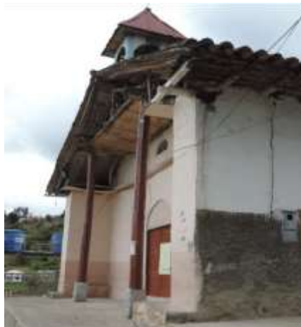
Fotografía N° 88: Instalaciones eléctricas – medidor de luz
