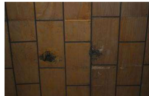
Fotografía N° 131-V1. 132-V2. 133-V3.: Restauración del cielo raso.
