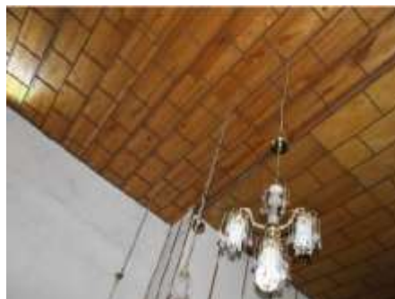
Fotografía N° 89: Instalaciones de lámparas.
