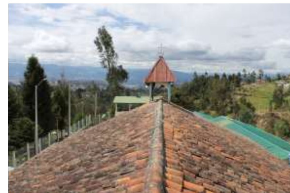
Fotografía N° 30: Vista al campanario.
