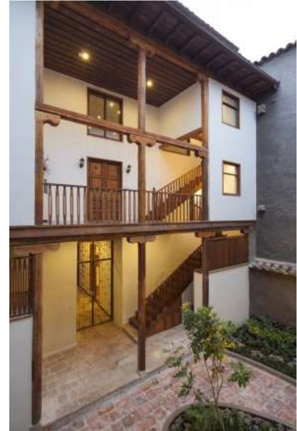
Imagen N° 27: Rehabilitación de la estructura – Casa Jaramillo - Cuenca.
