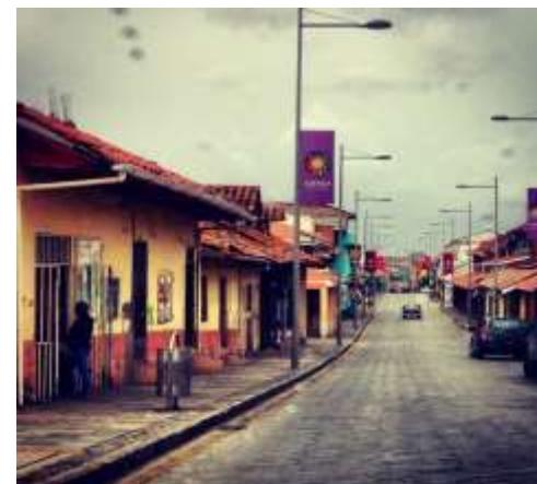
Imagen N° 26: Edificaciones con impacto negativo y sin valor – Av. Loja.
