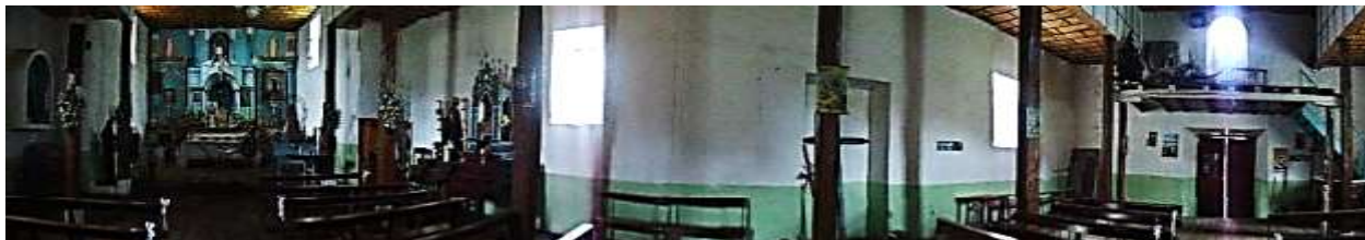
Fotografía N° 55: Panorámica interior – Enlucido.
