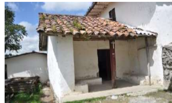
Fotografía N° 144-V11: Reintegración de la columna posterior.
