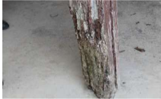
Fotografía N° 145-V11: Reintegración de la columna posterior.
