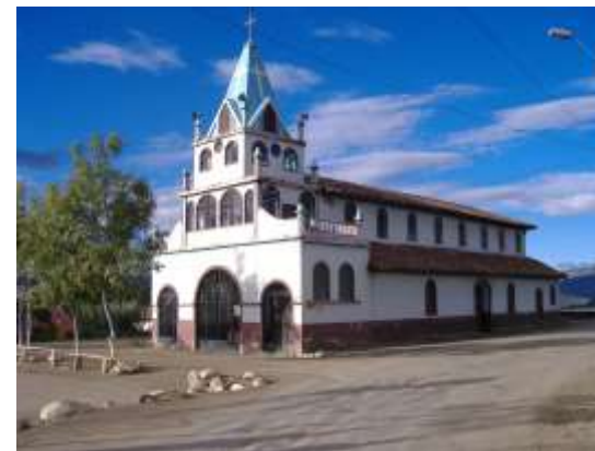
Imagen N° 28: Vistas de la Iglesia de Challuabamba.
