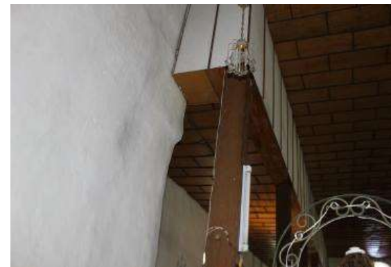
Fotografía N° 90 y 91: Instalaciones de toma corrientes
