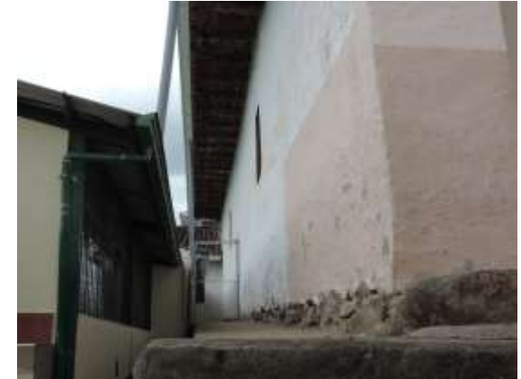
Fotografía N° 11: Vista de la cimentación corrida.
