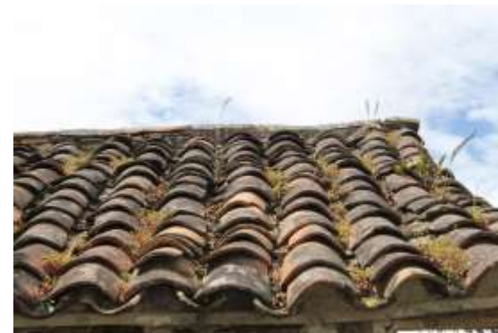
Fuente: Fernando Narea Alvarez. Archivo: recopilación realizada por el autor del Trabajo de Graduación.
