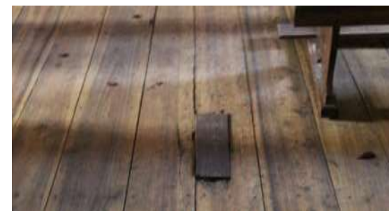
Fotografía N° 140-V15: Restauración del piso.
