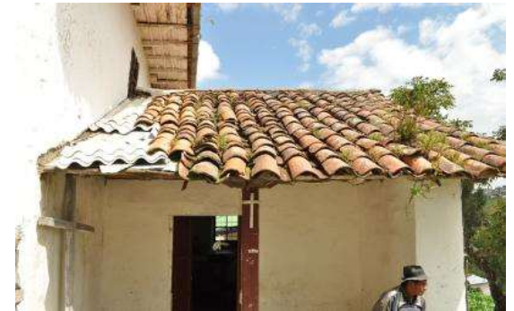
Fotografía N° 148-V17: Restauración de la cubierta de la sacristía.
