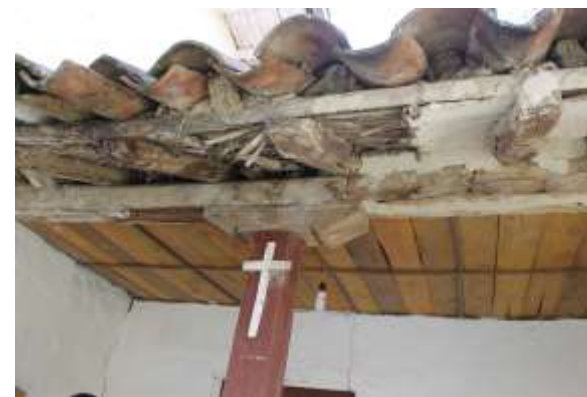
Fotografía N° 53: Cielo raso del portal posterior.
