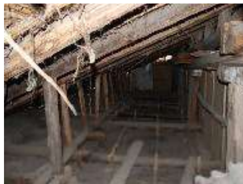
Fotografía N° 32: Vista de la estructura de la nave lateral – estructura del cielo raso.
