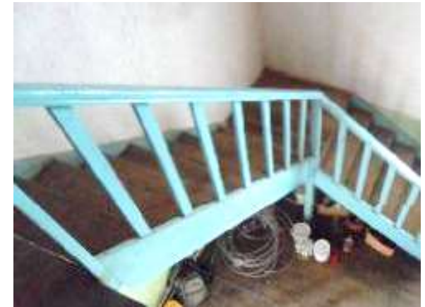
Fotografía N° 80, 81 y 82: Vistas de la grada y el pasamano.
