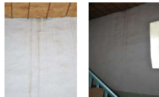
Fotografía N° 138-V13. 139-V14: Restauración del cielo raso.
