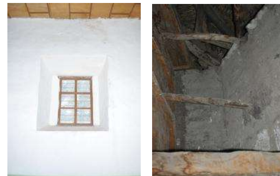
Fotografía N° 134-V4. 135-V5. 136-V6. 137-V7: Restauración del revoco.
