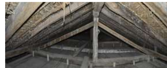
Fotoarrafía N° 31: Vista al campanario.
