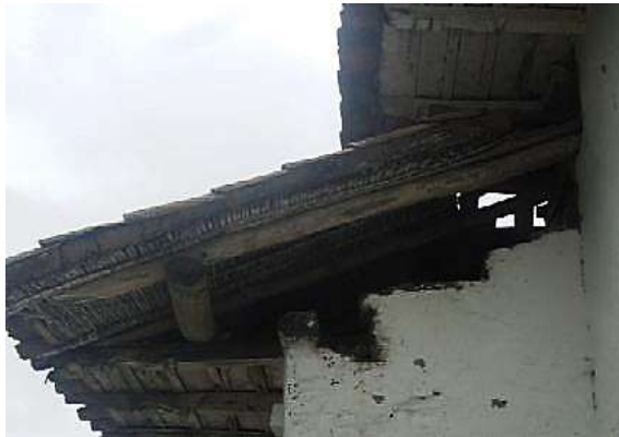
Fotografía N° 150-V15: Restauración del revoque y elementos estructurales.
