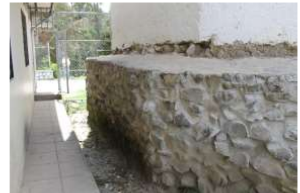
Fotografía N° 12: Vista del Muro de Contención.
