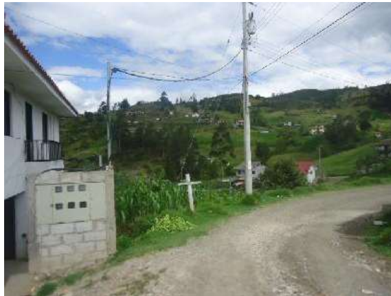
Fotografía N° 95: Vista de la primera curva.
