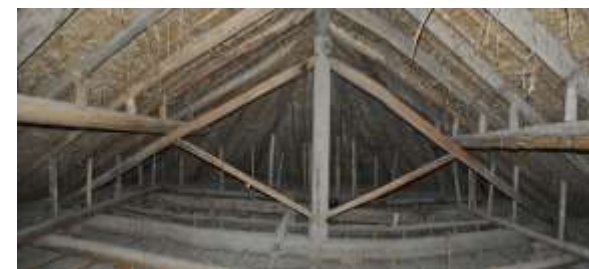
Fotografía N° 34: Vista de la estructura del Presbiterio.
