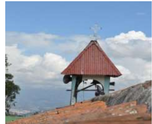
Fotografía N° 151-v18: Restauración de la cubierta.
