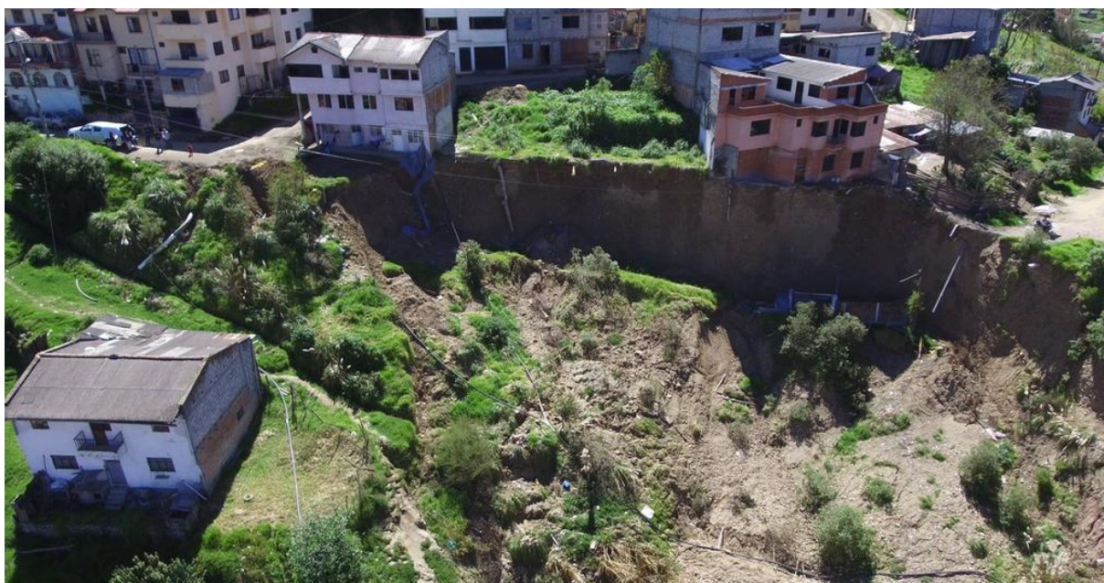
FIGURA 3.9: Viviendas en zona de riesgo Ciudadela Jaime Roldós - Fuente: Diario El Mercurio, 2012
