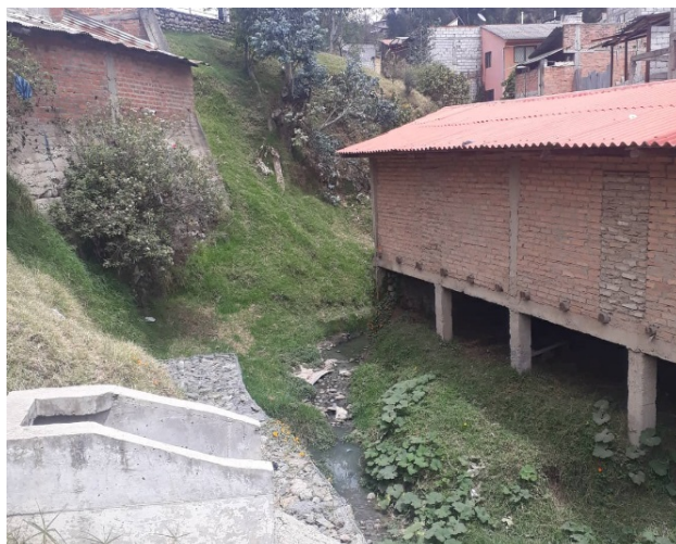
FIGURA 3.4: Viviendas construidas en la margen de proteccion de la quebrada Milchichig Fuente: Autor.
