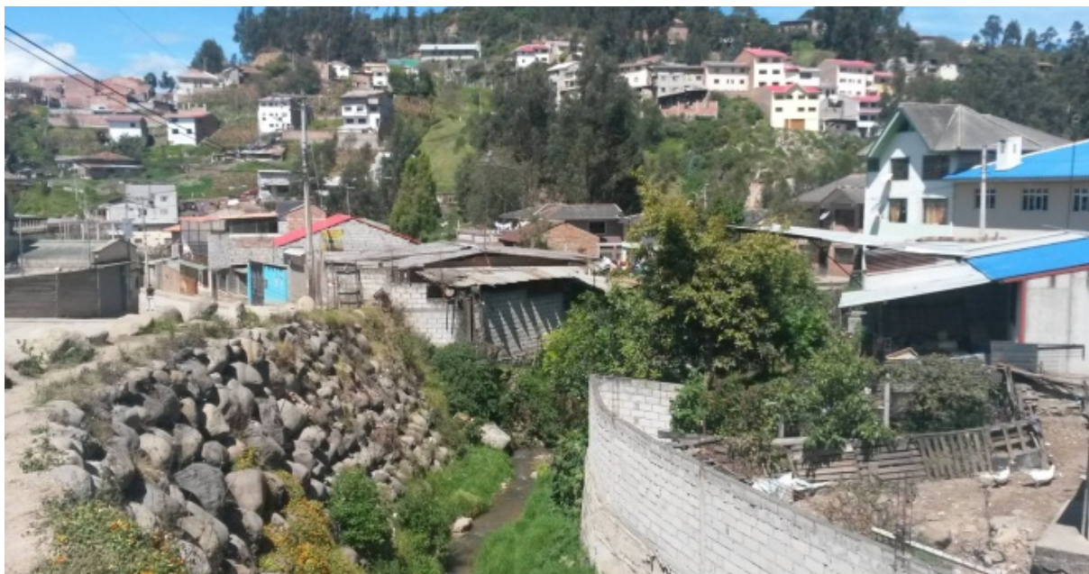
FIGURA 3.10: Edificaciones emplazados en la quebrada Milchichig - Fuente: Autor.
