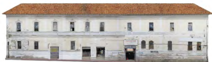
Fachada exterior de la calle Hermano Miguel (Bloque C)
