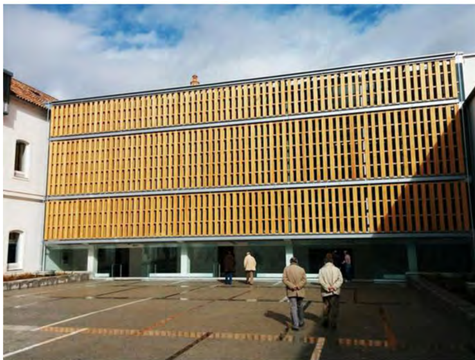
FIGURA 1.17: Implementación de la nueva obra. Fuente y elaboración: Cotelo (2010).
