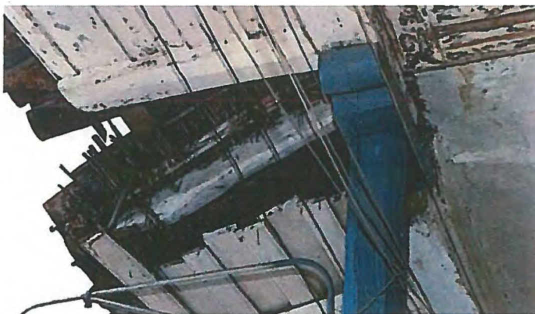
FIGURA 2.5: Discontinuidad en el alero. Fuente: Herrera & Tómmerbak (2017)
