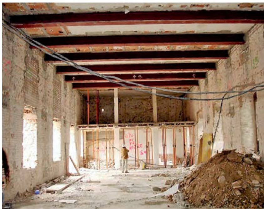
FIGURA 1.14: Refuerzo con vigas metálicas. Fuente y elaboración: Cotelo (2010).
