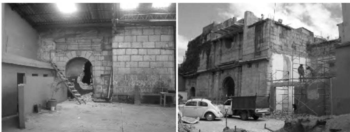
FIGURA 1.23: Liberación de los muros agregados. Fuente y elaboración: Nogales (2000).
