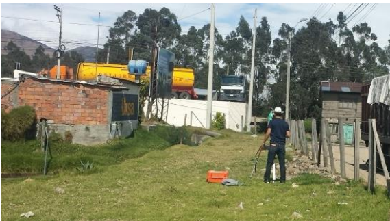
Fig.4: Levantamiento topográfico con estación total
