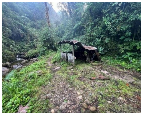
Figura 84: Fotografía de la Infraestructura preexistente.
