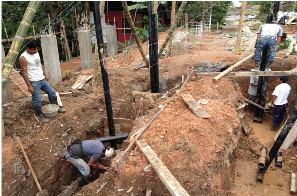
Figura 43: Fotografía de trabajo en excavación y armado de la cimentación mixta Napo Wildlife Center Ecolodge.
