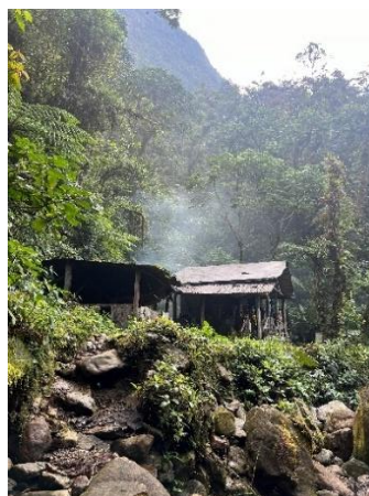
Figura 77: Fotografía sobre el refugio preexistente.
