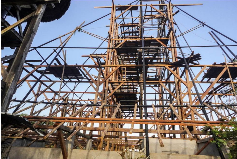
Figura 39: Fotografía acerca del armado de la estructura de madera Napo Wildlife Center Ec lodge.
