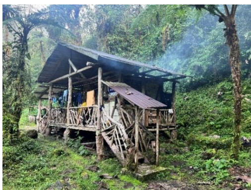
Figura 83: Fotografía de la Infraestructura existente.
