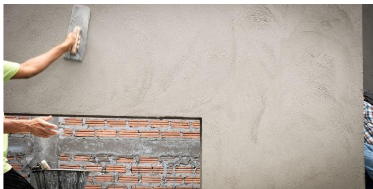
Figura 16: Proceso de enlucido de pared
