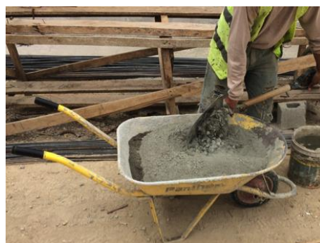
Figura 26: Arena, grava y cemento dosificado referente 1
