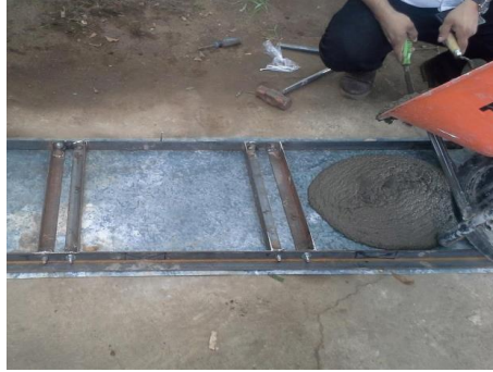
Figura 40: Colocación de la mezcla en los moldes referente 2
