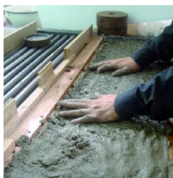
Figura 50: Colocado de la malla como refuerzo referente 3
