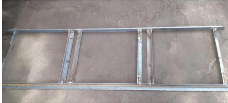
Figura 37: Estructura del encofrado referente 2
