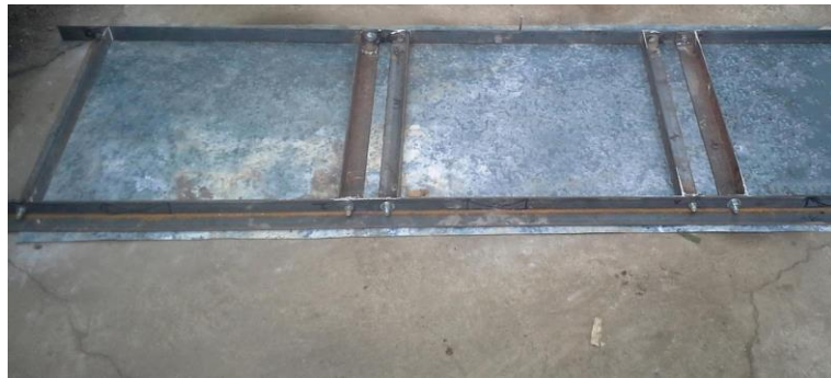
Figura 38: Encofrado utilizado referente 2
