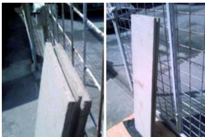
Figura 52: Sistema de machimbrado en el Panel referente 3
