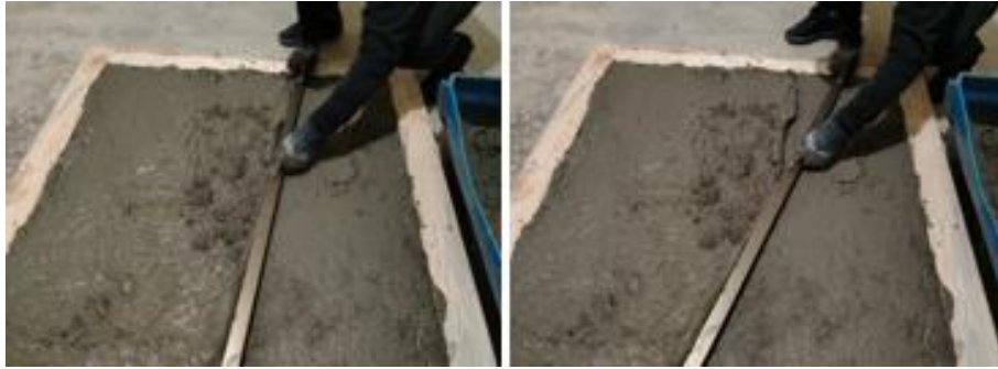
Figura 82: Nivelación de la mezcla con codal
