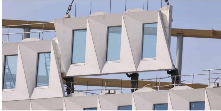
Figura 17: Montaje de pared prefabricada
