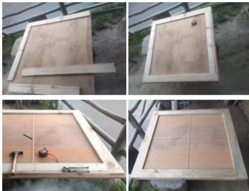
Figura 77: Fabricación de encofrado para prototipo
