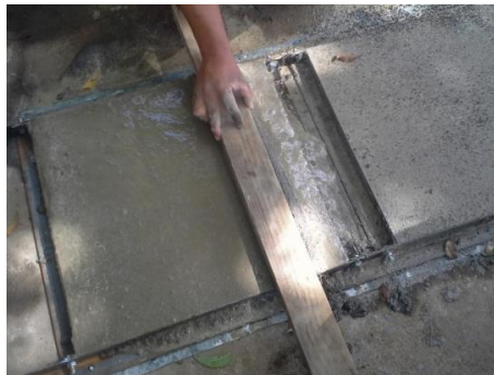
Figura 41: Nivelación y alisado de la superficie de los paneles con codal de madera referente 2
