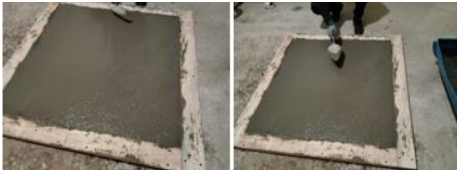
Figura 83: Nivelación de la mezcla con codal
