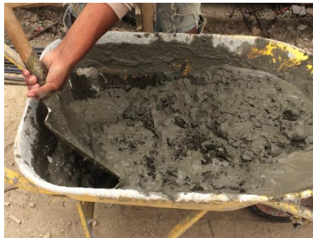
Figura 28: Arena, grava, cemento y agua según la dosificación referente 1
