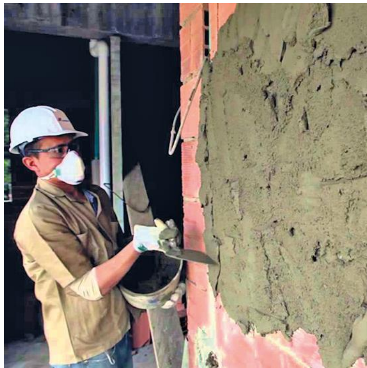
Figura 1: Proceso de enlucido de pared
