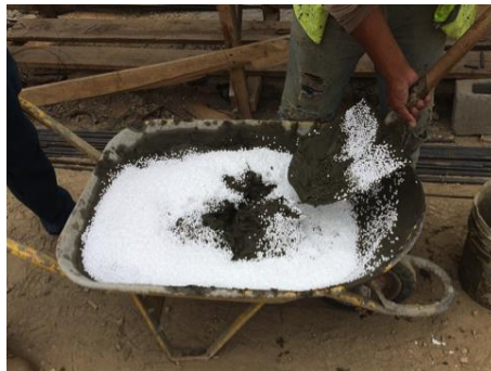
Figura 29: Adición de Espumaflex a la mezcla de hormigón referente 1
