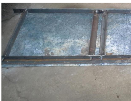
Figura 45: Moldes para los paneles referente 2
