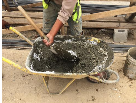
Figura 30: Mezclado de hormigón con aligerante (Espumaflex) referente 1
