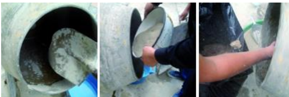
Figura 48: Agregado de materiales a la mezcladora referente 3
