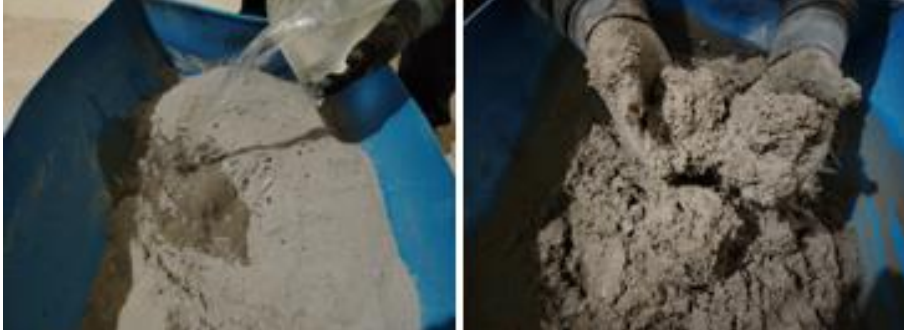
Figura 80: Adición de agua a la mezcla
