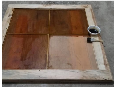
Figura 78: Aplicación de aceite al molde
