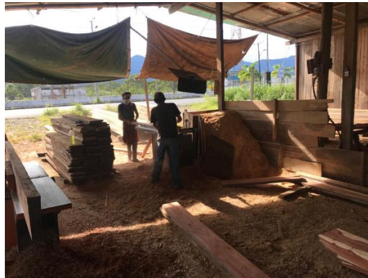
Ilustración 18 Cepillado de la madera Fuente: Propia
