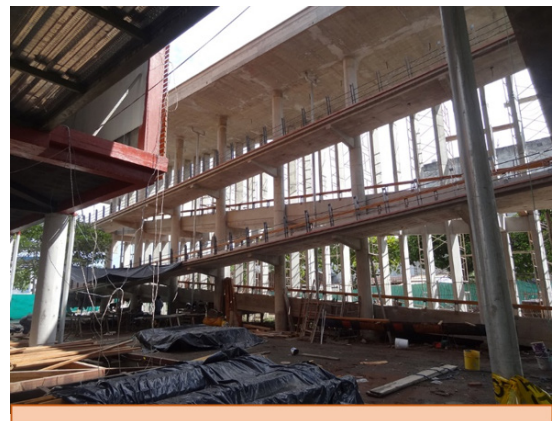
Rampa de Inclusión
