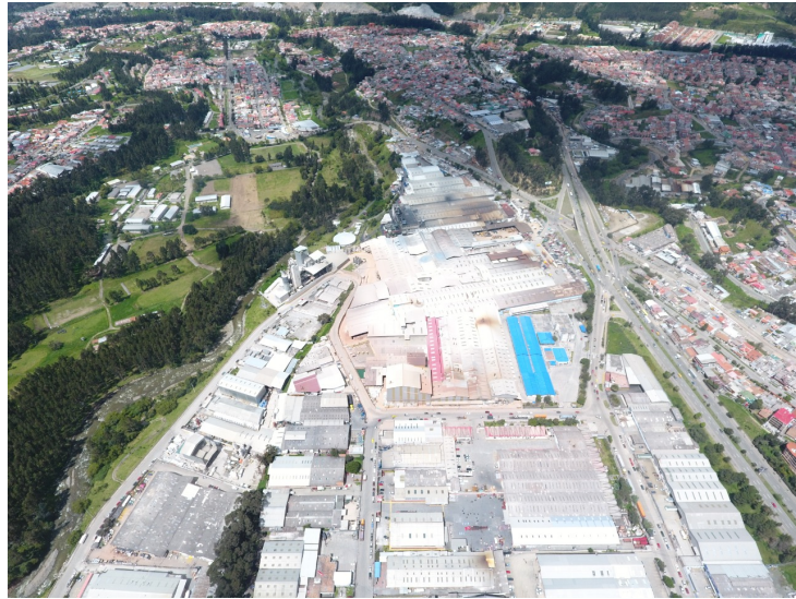
FIGURA 28: Consolidación de zona Industrial. Fuente: Fotografía propia. Tipo: Imagen.
