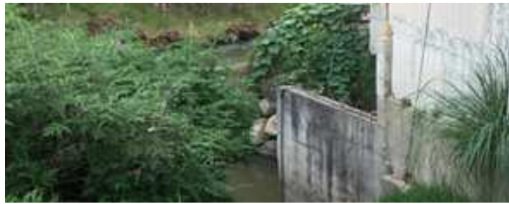
FIGURA 29: Choques visuales y contaminación. Fuente: Fotografía propia. Tipo: Imagen.
