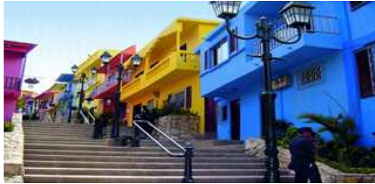
FIGURA 36: Regeneración Urbana en ciudad de Guayaquil, Ecuador. Fuente: Plataforma Arquitectura. Recuperado: 10/11/2019. Tipo: Imagen.
