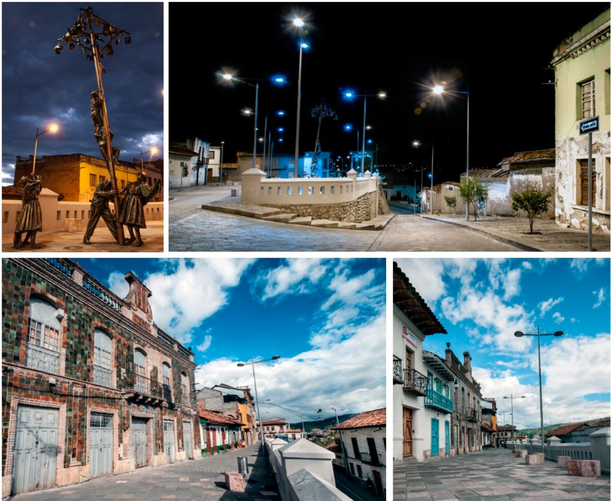
FIGURA 2.17: Imágenes de la Plazoleta de El Vado luego de ser rehabilitada.
