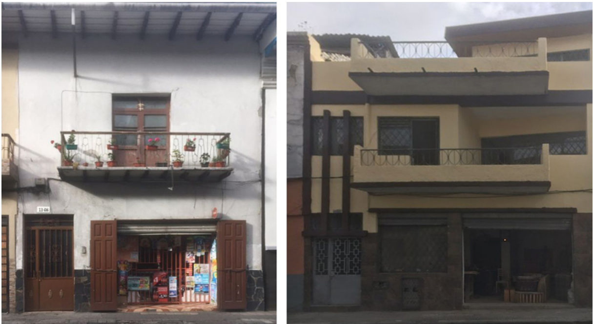
FIGURA 2.27: Imágenes de las edificaciones del predio 026 y 008 de uso multifamiliar. Fuente: Autor.
