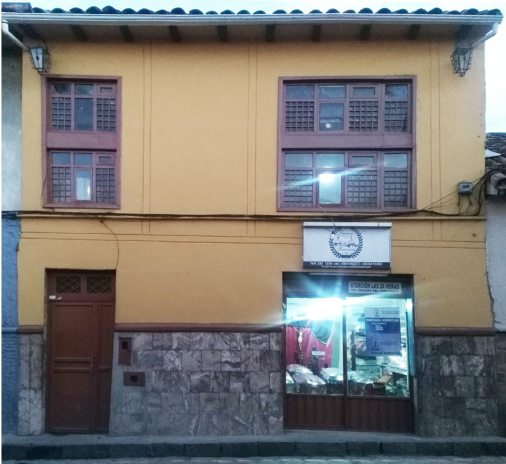
FIGURA 2.30: Imagen de la edificación del predio 015 con acceso peatonal limitado. Elaboración: Autor.
