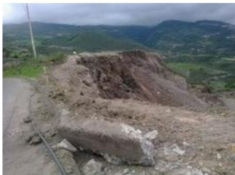
Fig. 4: Deslizamiento en el sector Puenteloma, 2010
