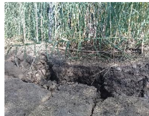
Fig. 24: Deslizamientos de Guabopamba. 2017 Fuente: Propia
