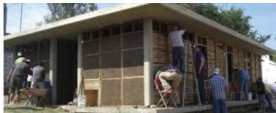
FIGURA 1.35: Recepción General de la CEDE. Fuente: https://acortar.link/r7n9yW . Elaboración: Plataforma
