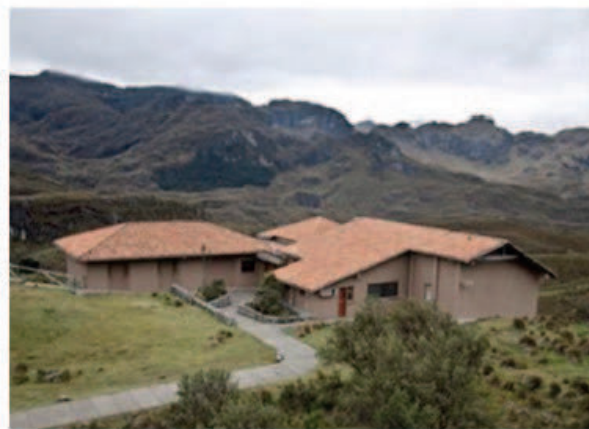
FIGURA 1.59: Áreas de esparcimiento. Fuente: https://acortar.link/1t9uGU . Elaboración: Etapa EP
