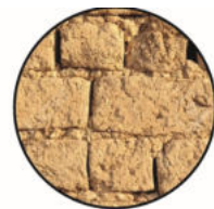
ADOBE ( MUROS EXTERIORES)
