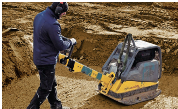
FIGURA 1.9: Preparación del terreno. Fuente: https://n9.cl/052ro
