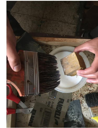
COLOCACIÓN DEL IMPERMEABILIZANTE
