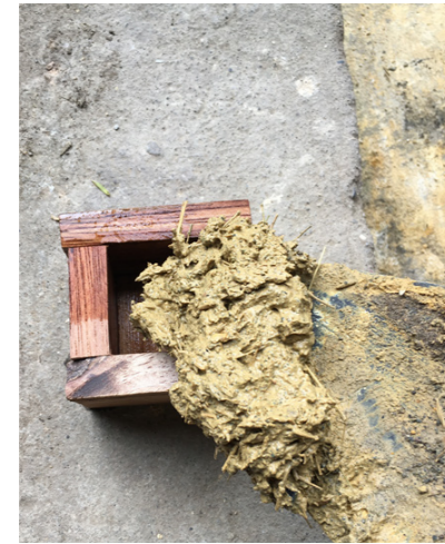
COLOCACIÓN EN EL MOLDE
