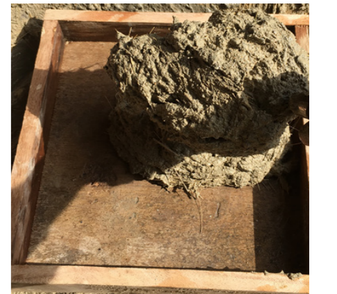
COLOCACIÓN DE LA MEZCLA EN EL MOLDE
