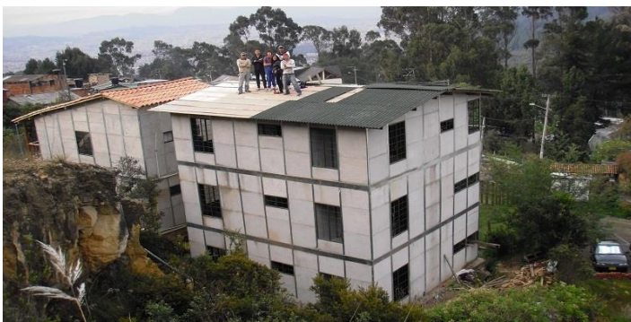
Figura 39: Edificación construida con sistema servivienda
