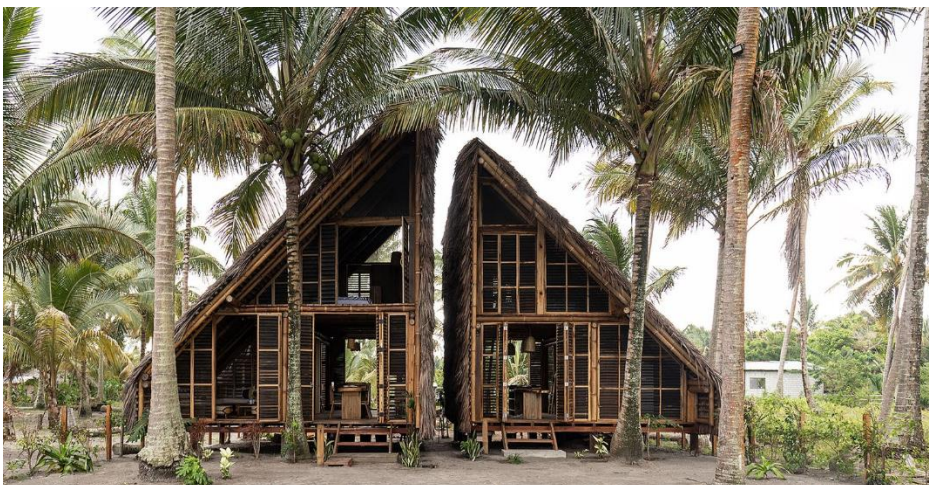
Figura 48: Proyecto Casa Toquilla ubicada en Portete, Ecuador
