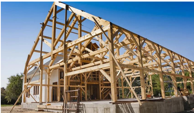
Figura 36: Estructura de madera en una casa
