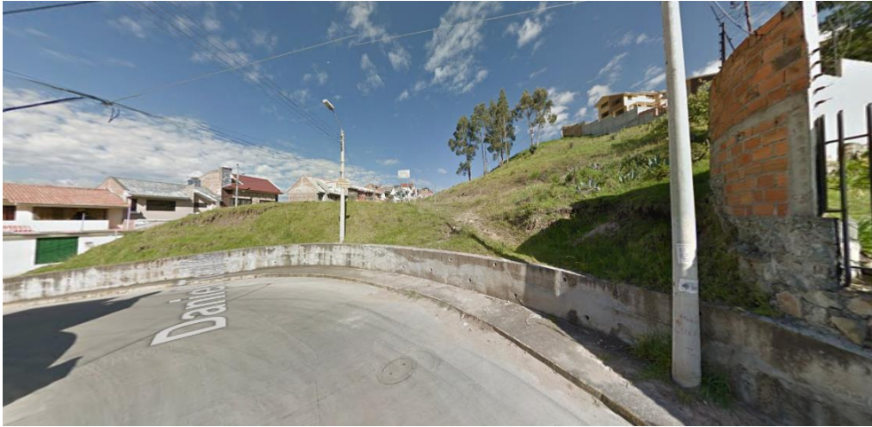
Figura 112: Foto del estado actual del terreno N°2
