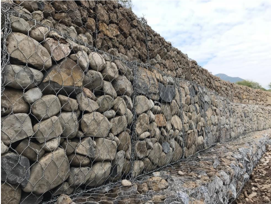
Figura 29: Muro de gaviones
