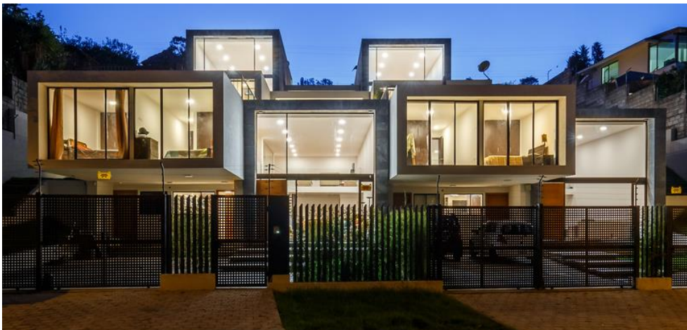
Figura 78: Fachada frontal de Casa FF
