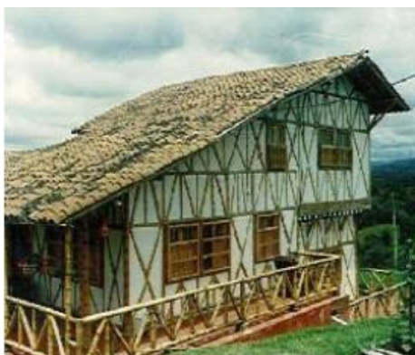
Figura 40: Edificación construida con sistema guadua
