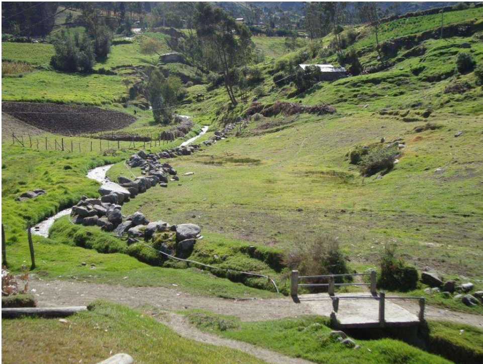
SITIO PARA LA PLANTA DE TRATAMIENTO PROYECTADA (FIN DEL COLECTOR).
