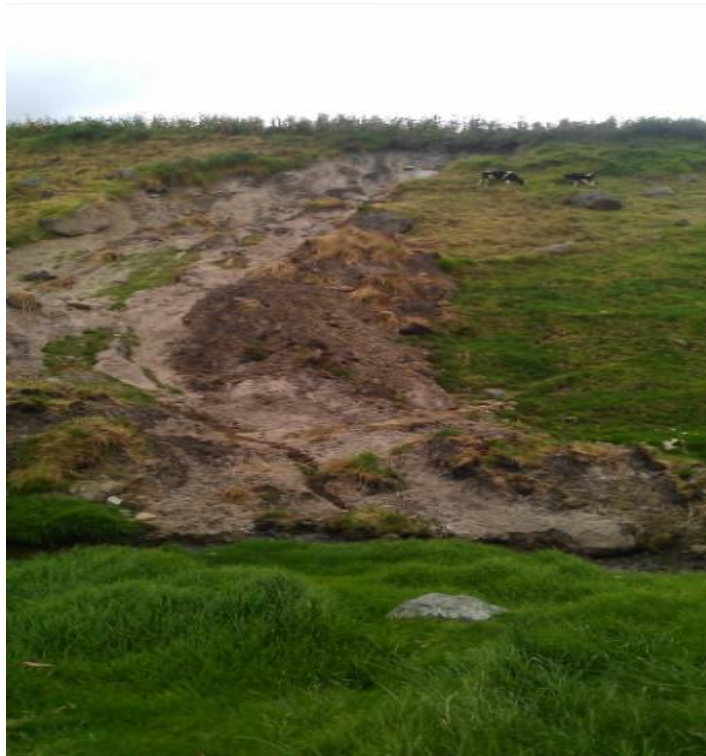
Fotografía 3-3 Zona con deslizamientos
