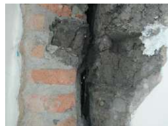
Figura 33: Estructura de adobe en conjunto con estructura de madera.
