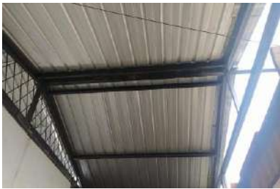
Figura 31: Estructura metálica de cubierta.
