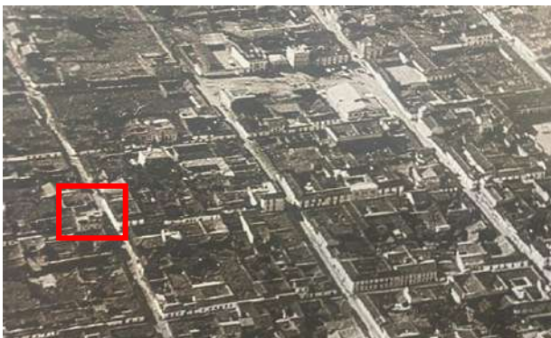
Figura 22: Fotografía aérea de Cuenca, mitad siglo XX, en la que se observa la edificación. Fuente: Monsalve (2008). Elaboración: Propia.
