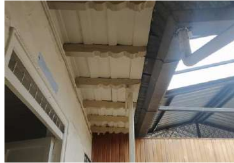
Figura 30: Estructura de madera cubierta.
