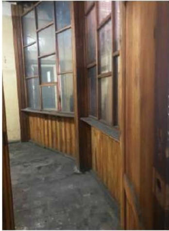
F1 Mampara de madera y recubrimiento de columnas
