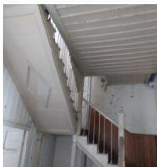
F5 Escaleras de madera y muro de bloques de cemento planta alta
