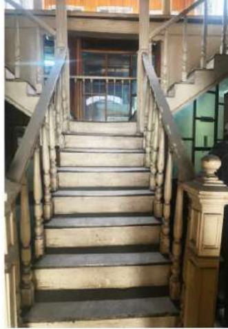
F2 Escaleras de madera planta baja
