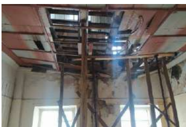
Figura 34: Cielo raso de tiras de madera con pintura.
