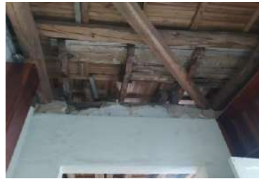
Figura 32: Estructura de madera piso.
