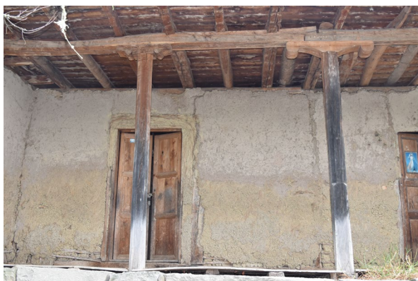
Foto 57: Luz entre columnas.
