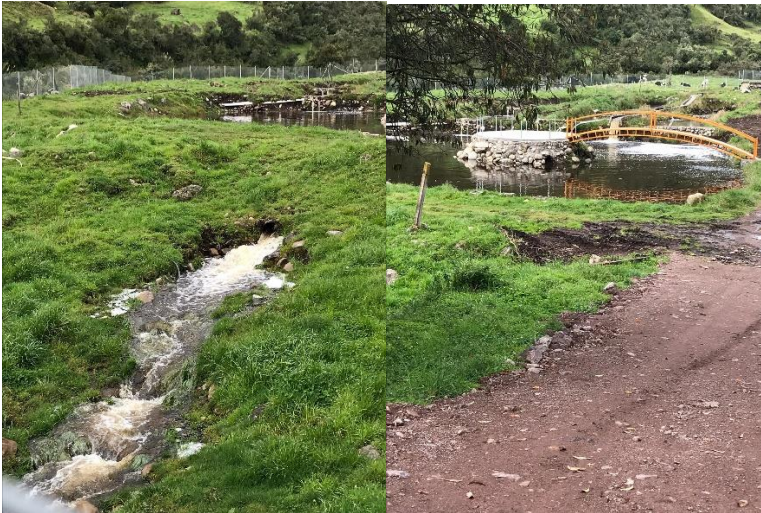
Figura 37: Contaminación antrópica por infraestructura en el punto 1
