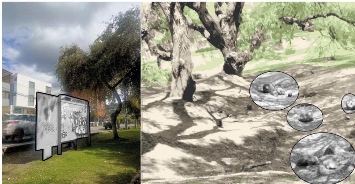
Figura 40: Deterioro urbano: abandono de paradas de buses y áreas verdes
