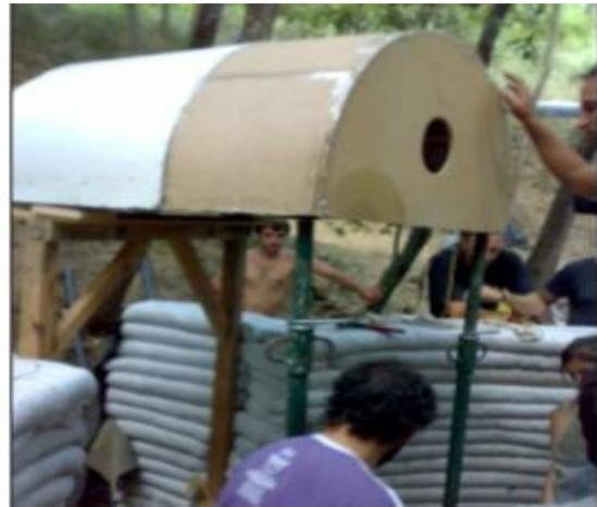
**Imagen 61:** Colocación provisional, marcos de madera en ventanas y puertas
