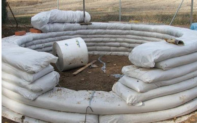
**Imagen 88:** Longitud suficiente en el extremo de los sacos para su sellado
