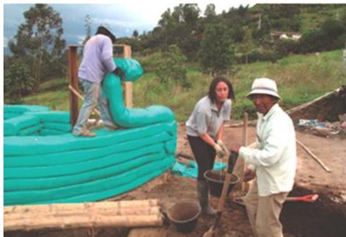
**Imagen 89:** Construcción de pared de superadobe
