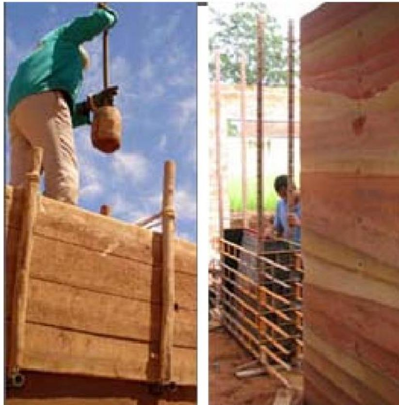
**Imagen 18:** Dos tipos de moldes para ejecución de la tapia: tapial tradicional (a la izquierda) y tapial metálico (a la derecha)
