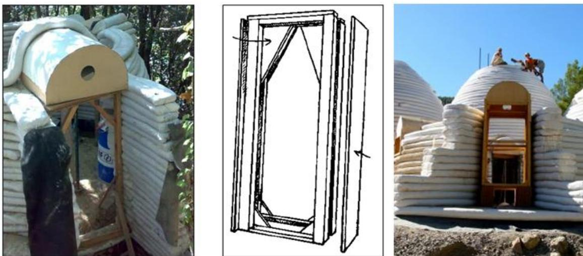
**Imagen 92:** Los refuerzos del marco, luego se retiran, los refuerzos del marco han de ser más anchos que la anchura del saco compactado.
