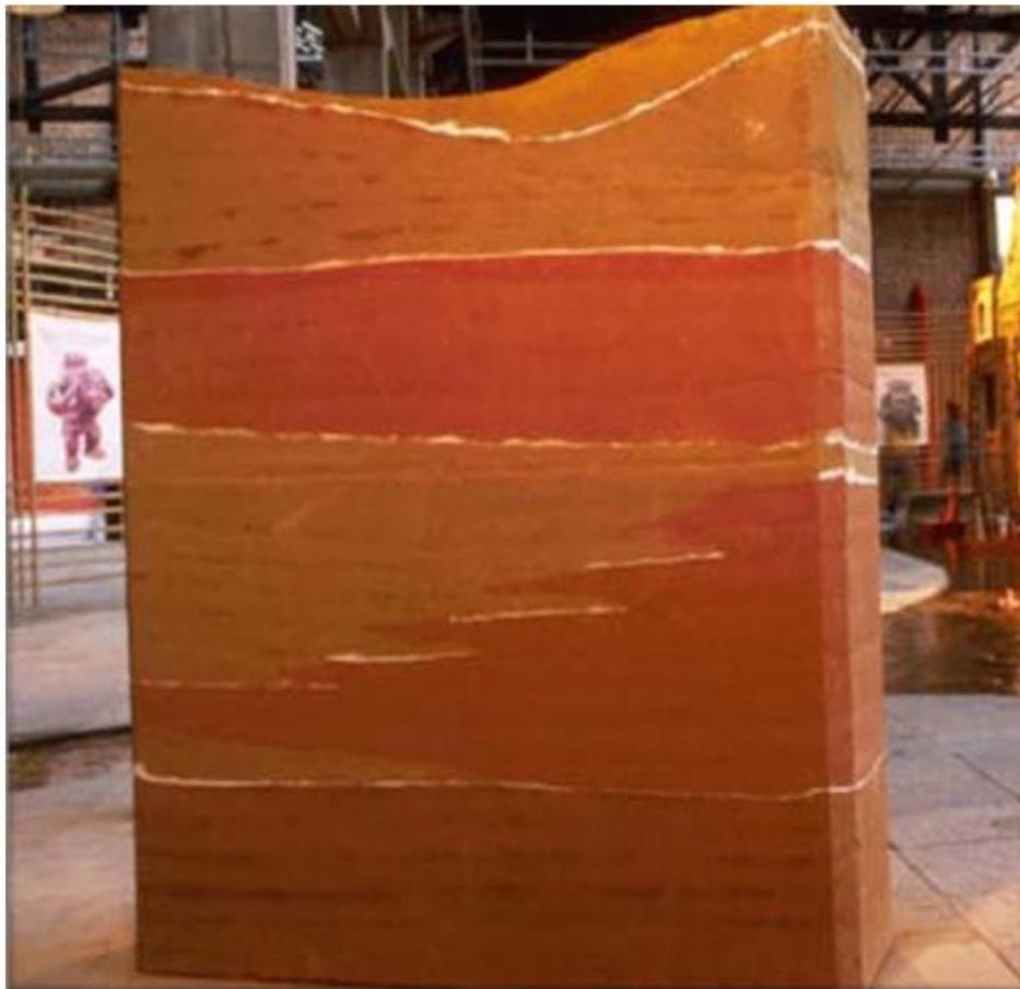
**Imagen 19:** Panel o muro de tapia con diferentes colores de tierra
