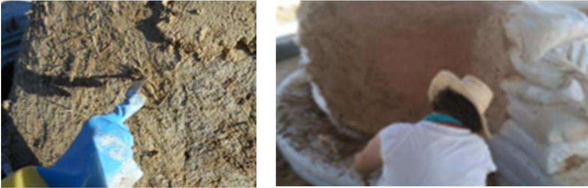
**Imagen 96:** Capa de revoco con paja, mezcla similar al Cob
