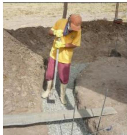
**Imagen 58:** Colocación, nivelación y compactación de grava en la cimentación
