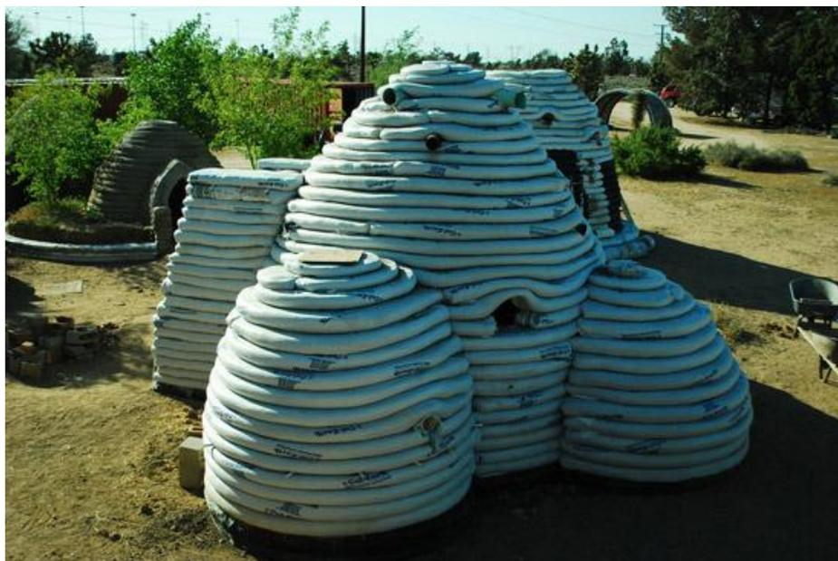
**Figura 37:** Cúpulas terminadas con sacos de arena
