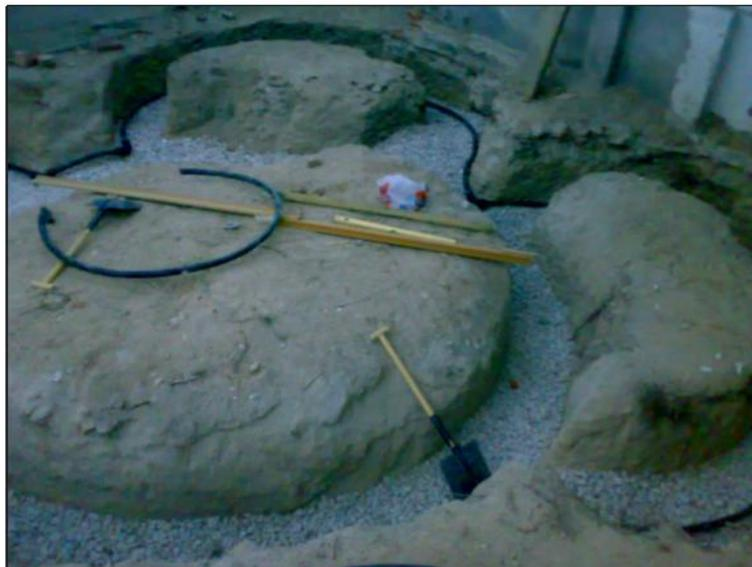
**Imagen 82:** Colocación del tubo de drenaje en el exterior de la zanja de cimentación, en este caso hay ábsides por lo tanto hay que colocarlo siempre en el exterior del edificio.
