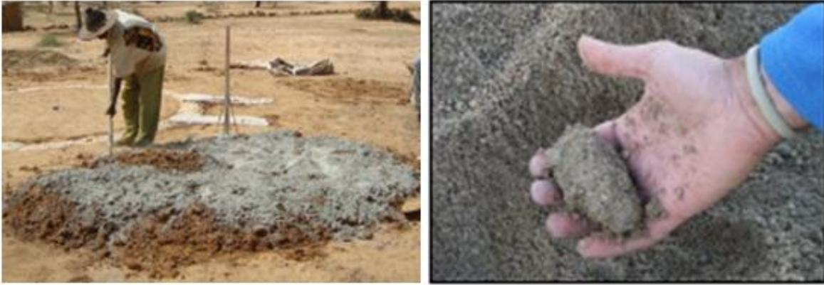
**Imagen 41:** Tierra dosificada, se le añade agua hasta adquirir un aspecto húmedo, pero no saturado
