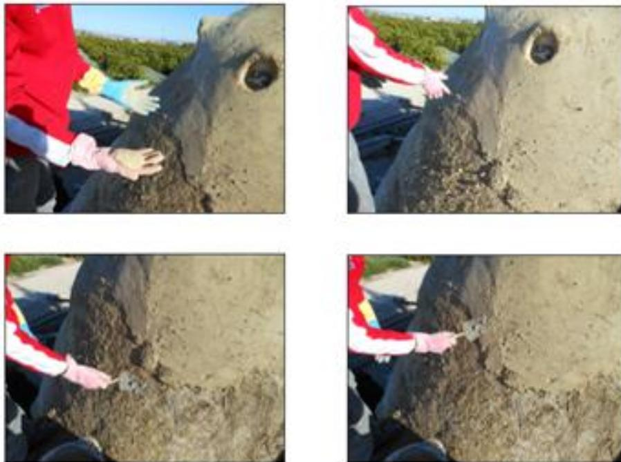
**Imagen 98:** Aplicación del revoco lanzando la mezcla contra el revoco de la 2<sup>a</sup> capa
