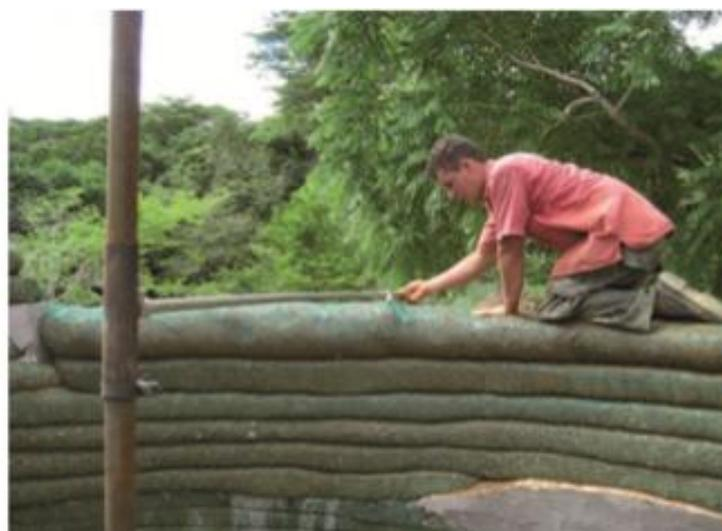
**Imagen 55:** Domo Semiesférico con radio o una cadena fija en el centro
