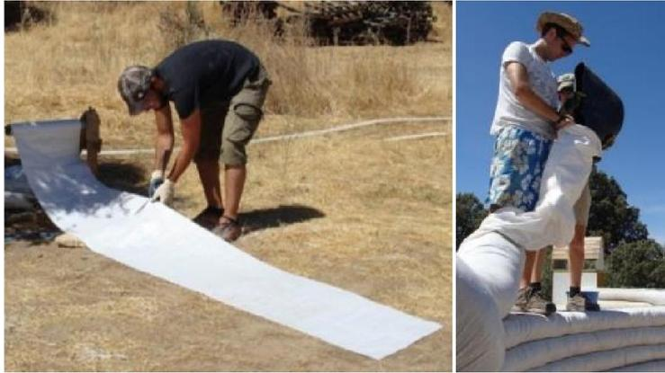
**Imagen 44:** Los sacos se suministran en rollos y se cortan a medida para cada hilada. En la fase de relleno los sacos actúan de encofrado.
