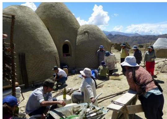
**Imagen 23:** Técnica de construcción con superadobe
