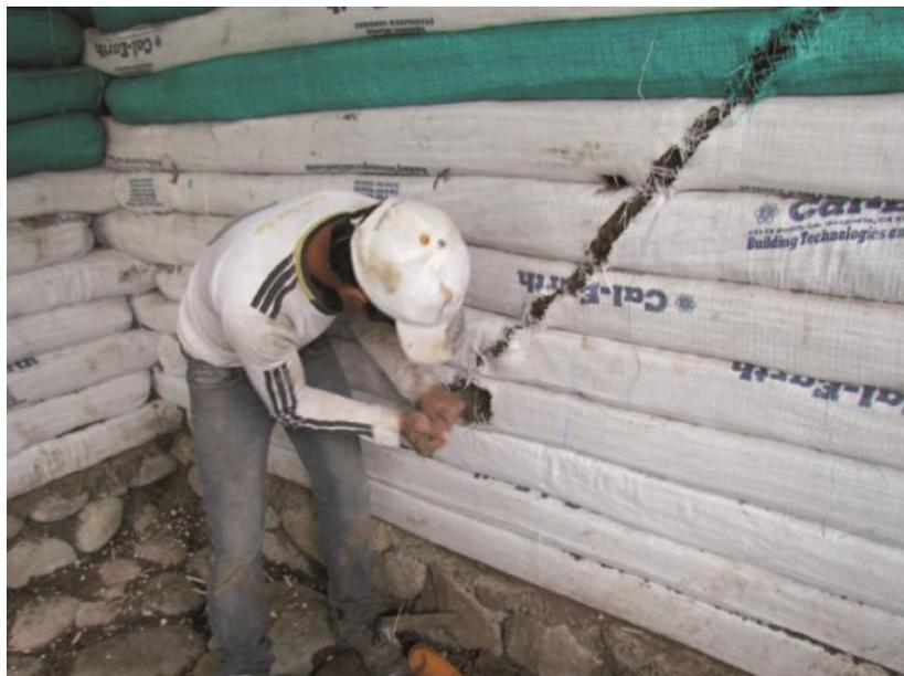
**Imagen 94:** Canal para la instalación eléctrica
