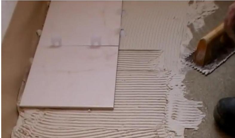
**Imagen 87:** Colocación de cerámica en el piso
