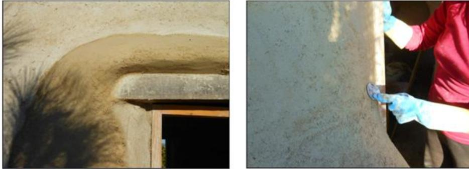
**Imagen 100:** Resultado de la última capa, aplastando con una cuchara metálica
