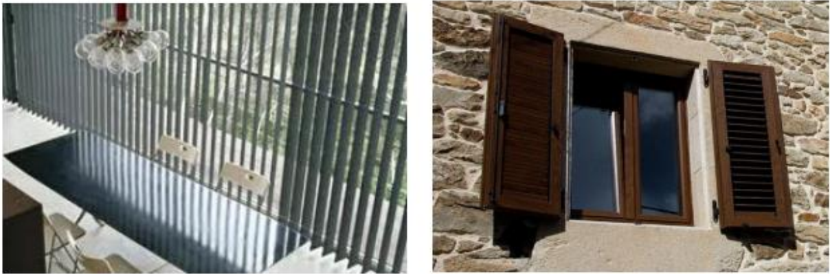
Imagen N° 36 Persianas verticales y contraventanas.
