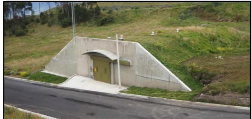
**Figura 7. Polvorín cubierto de tierra, en forma de arco oval en el Depósito Conjunto de Municiones "El Corazón"**
