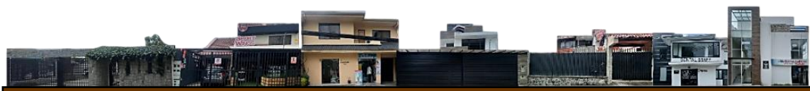
Figura 87: Tramo 3, calle Vega.T
