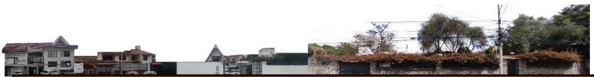
Figura 86: Tramo 2, calle Miguel Cordero Dávila
