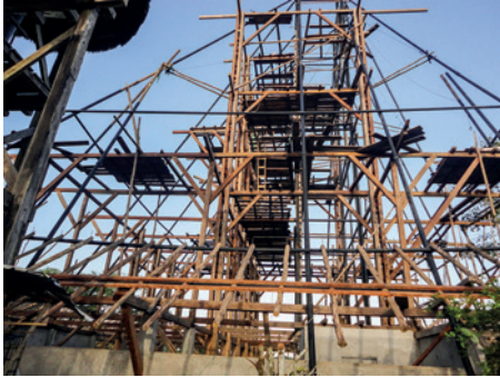
b Tubos perforados Torre Wildlife Center - Napo
