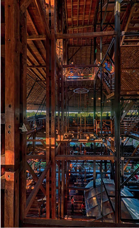
a Estructura Mixta Torre Wildlife Center - Napo
