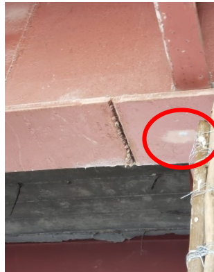
Imagen 6. Lijado de la superficie.
