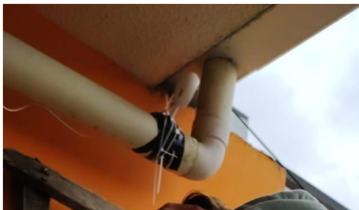
Figura 18: Instalación de la cámara
