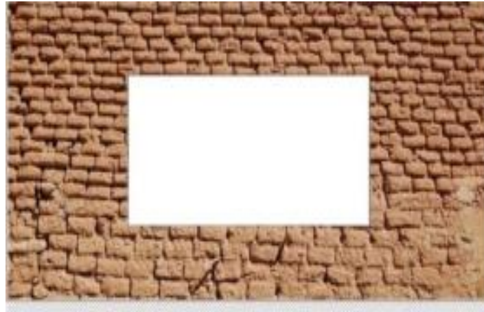
Figura 4. Muro de adobe con abertura de ventana. Fuente: (Chacón, Suquillo, Sosa, et al., 2021)
