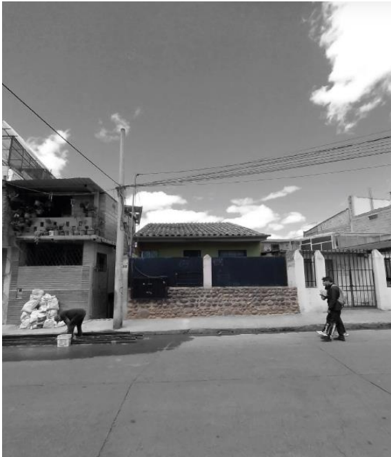
Figura 90: Fachada frontal, lote E Elaboración: Grupo de tesis
