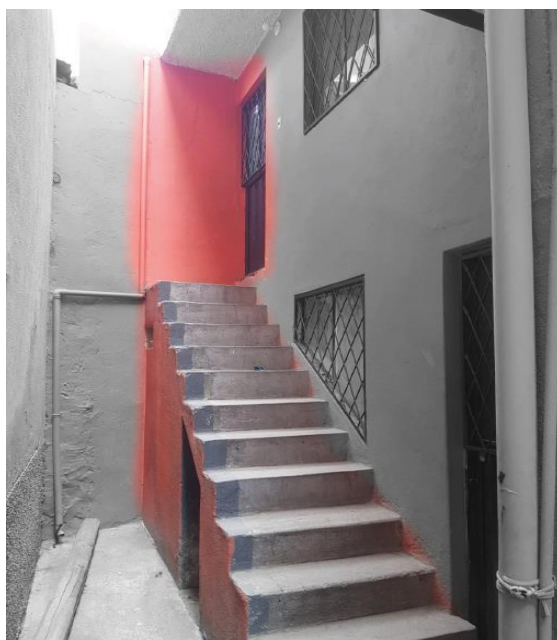
Figura 93: Acceso al lote G Elaboración: Grupo de tesis
