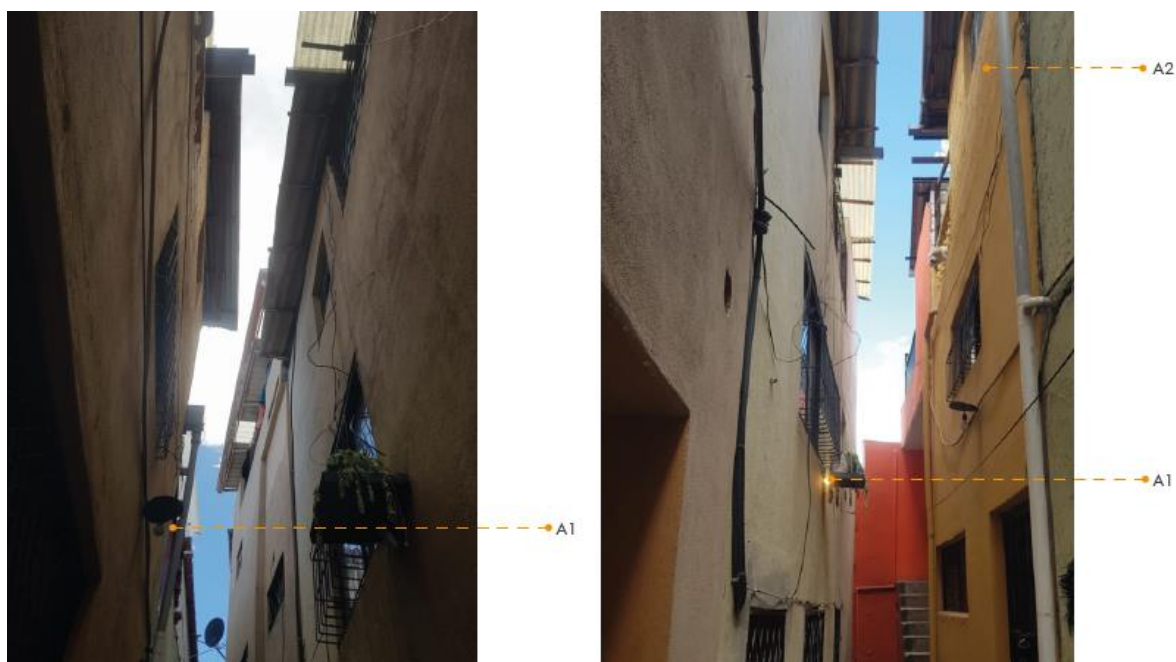
Figura 105: Vivienda, lote F Elaboración: Grupo de tesis
