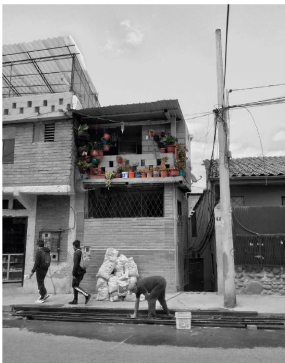
Figura 81: Plantas Ornamentales en la fachada Elaboración: Grupo de tesis
