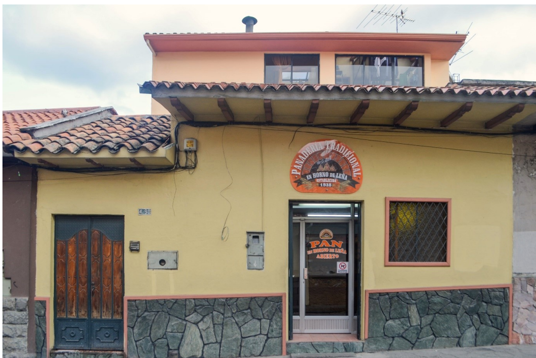
FIGURA 3.46: Fotografía 37: Vivienda (Estado actual) Fuente: Elaborado por el autor de tesis, 2019.
