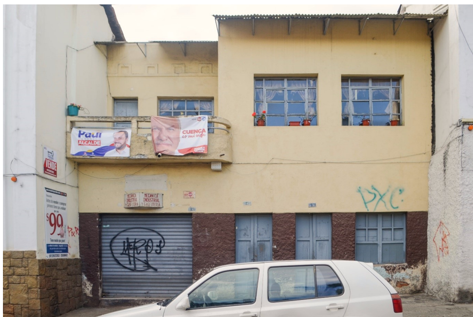
FIGURA 3.19: Fotografía 26: Vivienda (Estado actual) Fuente: Elaborado por el autor de tesis, 2019.
