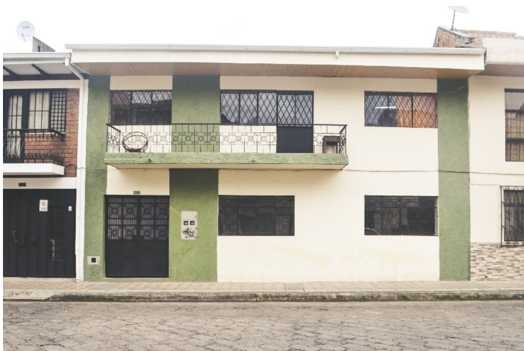
FIGURA 3.33: Fotografía 32: Vivienda (Estado actual). Fuente: Elaborado por el autor de tesis, 2019.
