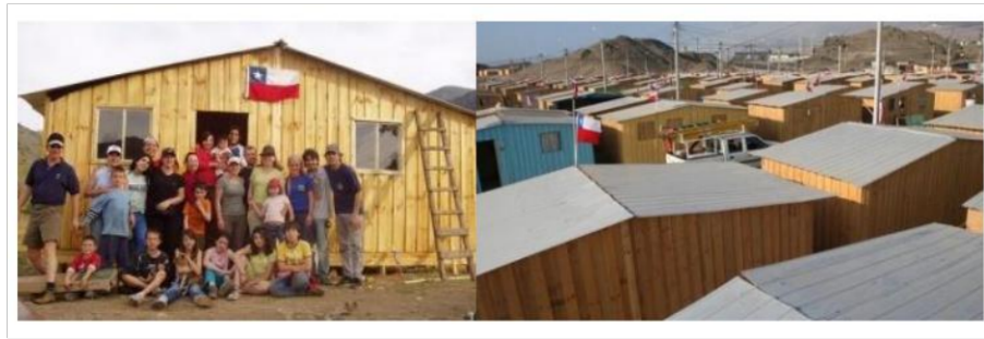
FIGURA 1.28: Mediaguas en Chile construidas tras el terremoto de Tocopilla en 2010. Tomada de http://www.biobio proyecta.cl 2010 05 06 las mediaguas estandar de viviendas de emergencia
