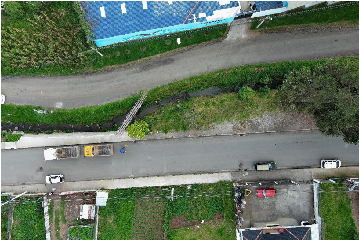
Figura 56: Vista del Río Checa Elaboración: Propia
