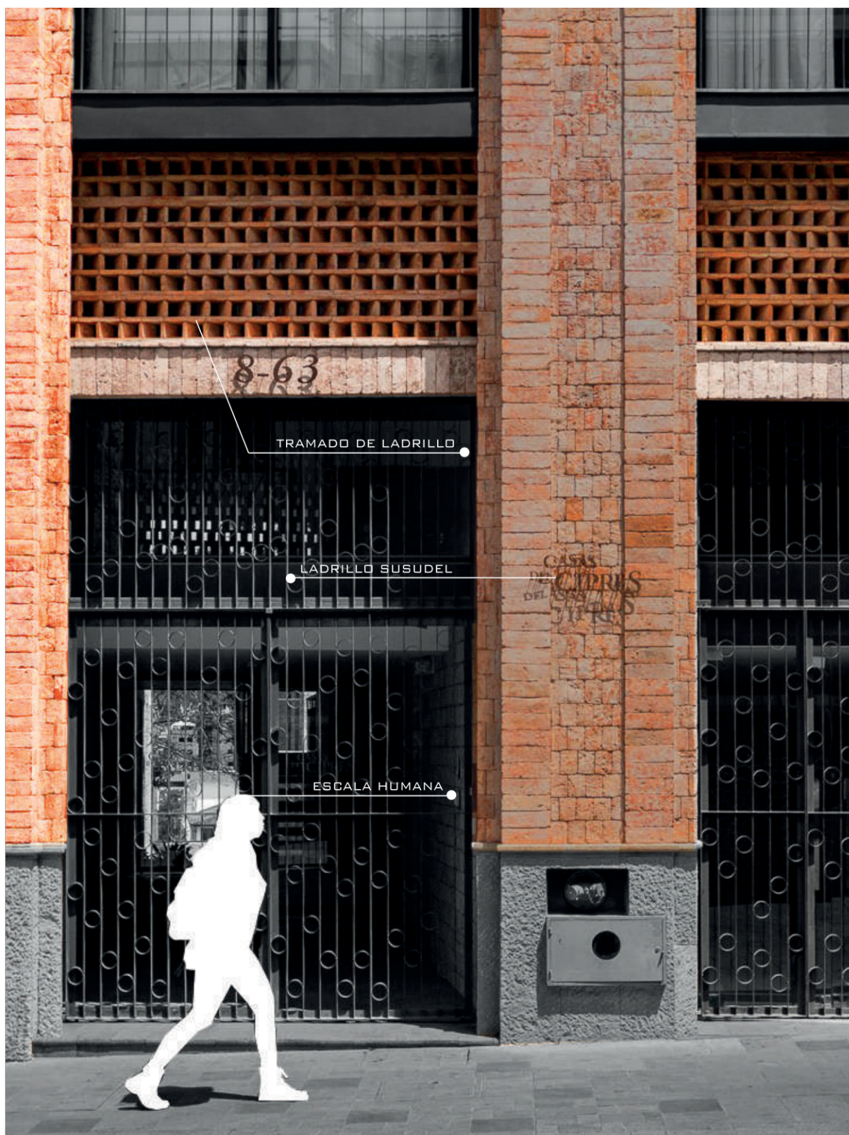
Figura 1.44: Fotografía externa - Vista desde la Calle Larga
