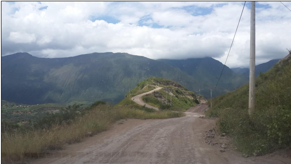
Vía Montañosa de Patapata
