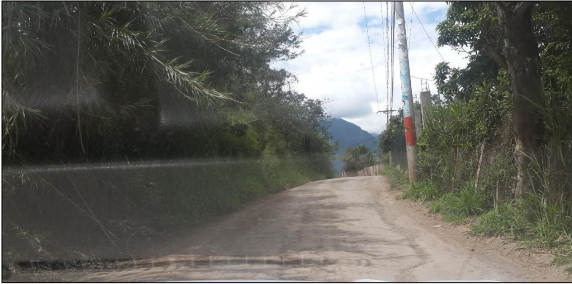
Parte de la Vía en Donde se Observan los Postes Eléctricos
