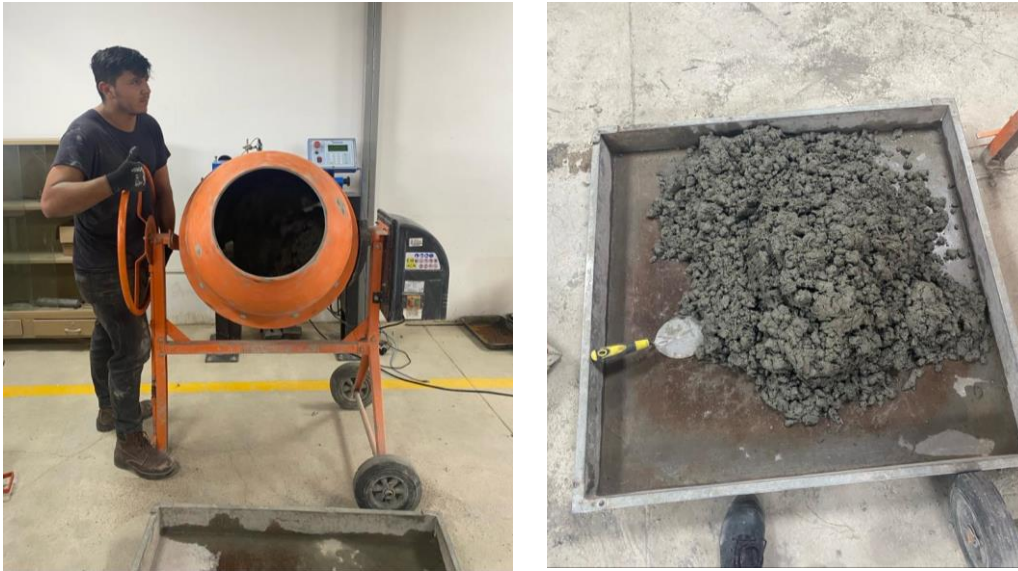
Ilustración 25: Proceso y vaciado de la mezcla de hormigón.
