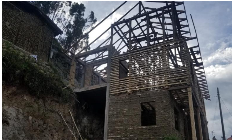
Figura 16: Estructura de bahareque.
