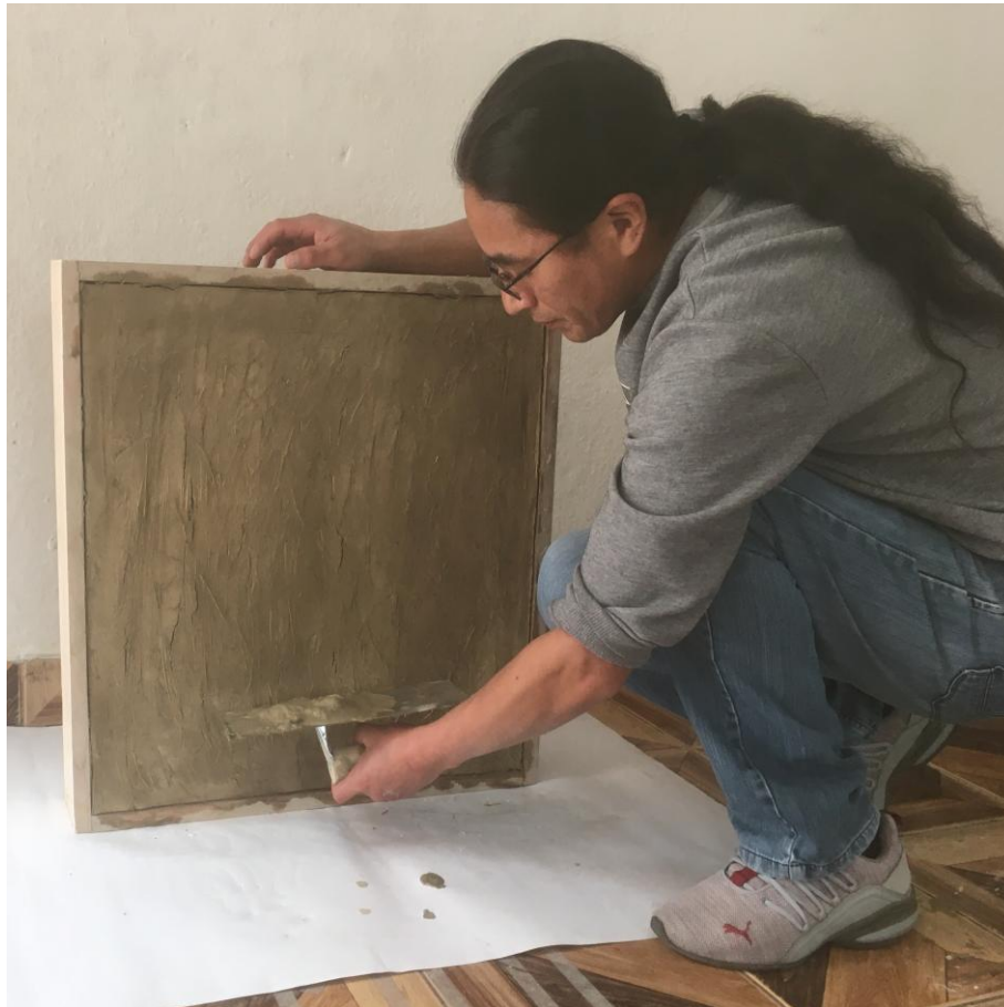
Figura 113: Revoque final o capa superficial.
