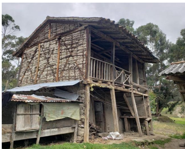
Figura 8: Construcción con bahareque.
