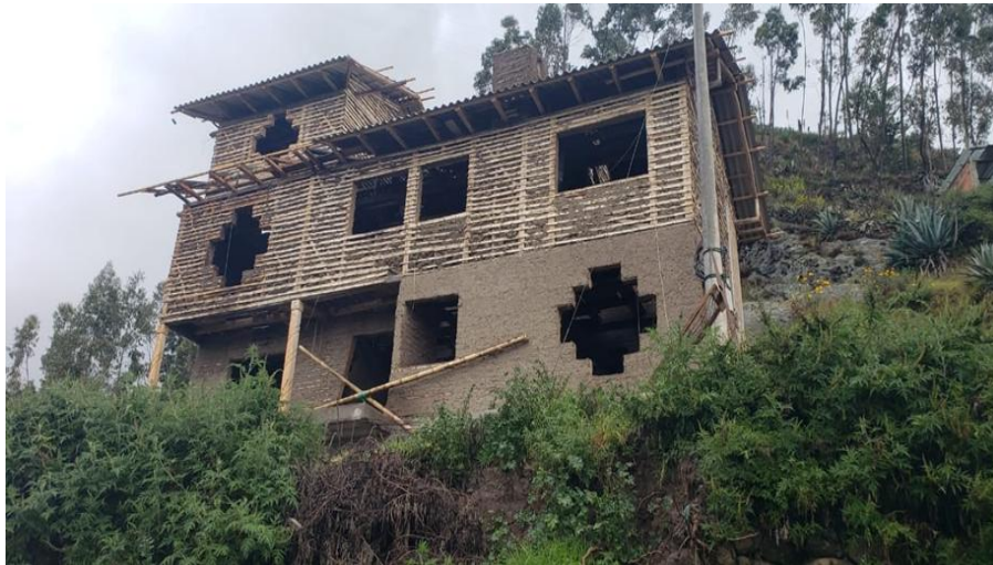
Figura 10: Estructura de bahareque.
