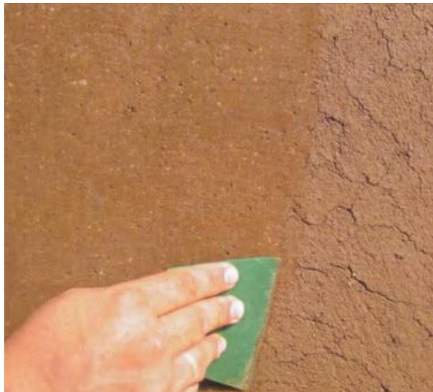
Figura 19: Alisado de revoque de tierra.
