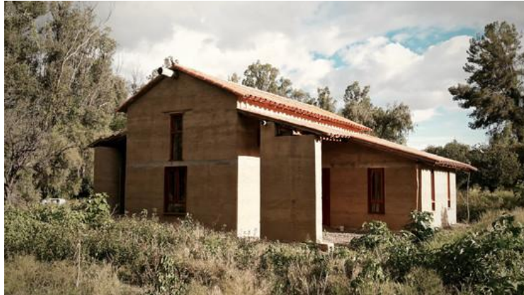
Figura 27: Casa Experimental de Tapial.
