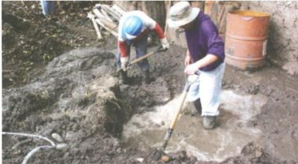
Figura 41: Mezclado de material.
