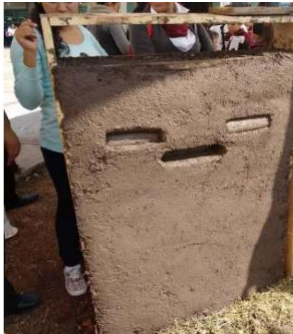
Figura 47: Relleno de revoco grueso en panel.
