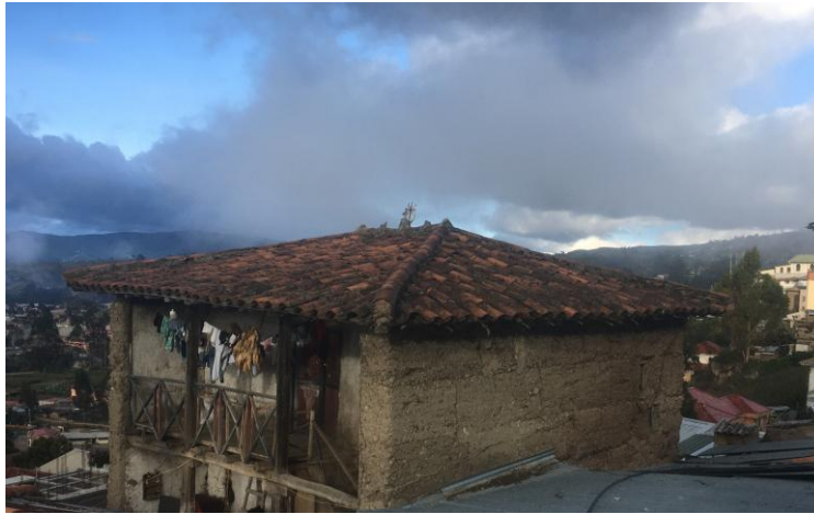
Figura 7: Construcción con tapial.
