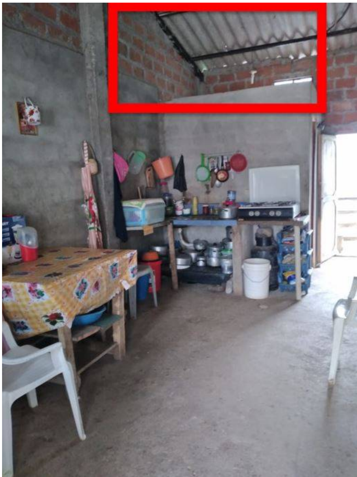
FIGURA 2.60: Estructura de la cubierta metálica – Fuente: Entrevistados - Elaboración: Christian Díaz.
