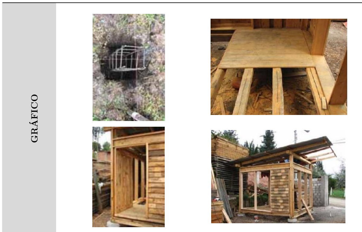
Construcción, vivienda económica - Fuente: Patricio Álvarez Calle y Diego Proaño Escando - Elaboración: Christian Díaz
