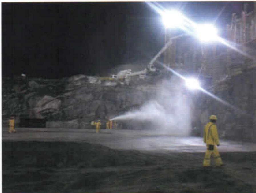
**CURADO DEL HORMIGÓN MEDIANTE ASPERSIÓN**
