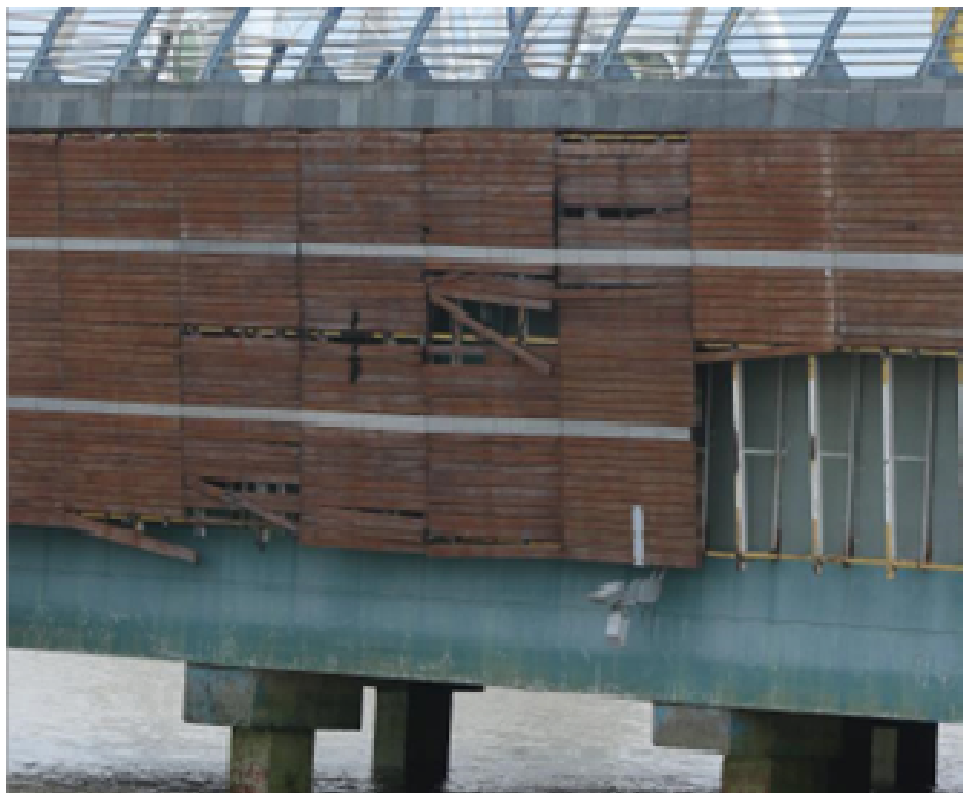
FIGURA 2.54: Como se encuentra funcionando actualmente el Malecón 2000. Fuente: (Urvia, 2010)
