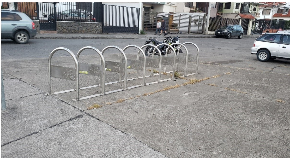
FIGURA 4.11: Verificación de estado de mobiliario parque Iberia Fuente: Propia
