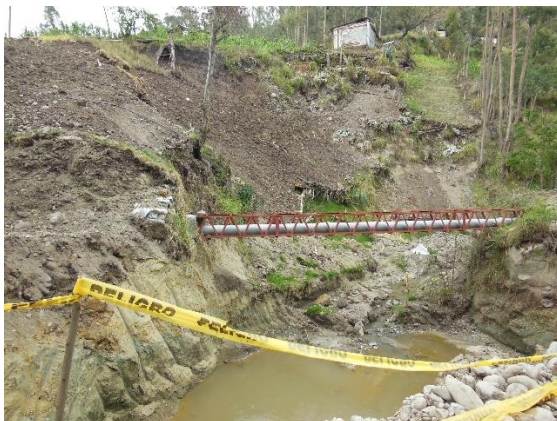
Foto. 3 Derrumbe a causa de la quebrada El Solitario. Elaboración: Jorge Eduardo Moyano Rios
