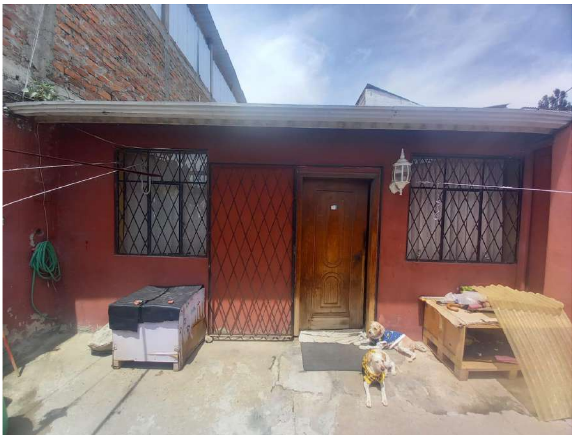
Figura 39: Levantamiento Fotográfico Fuente: Autor. Elaboración: Autor
