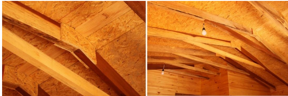
Fig. 62. Conector tipo placa de madera en cubierta
