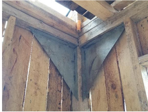
Fig. 65. Colocación de placas en forma triangular en viga-columna
