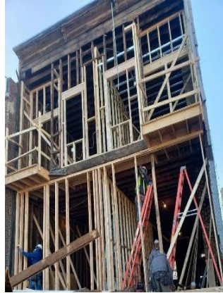
Fig. 2. Estructura de una vivienda de madera
