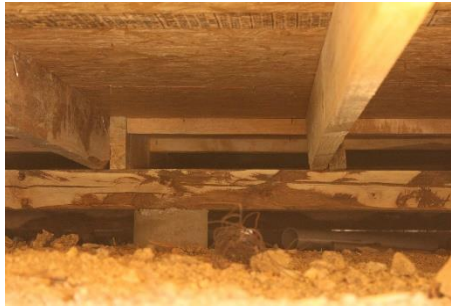
Fig. 48. Vigas principales y secundarias
