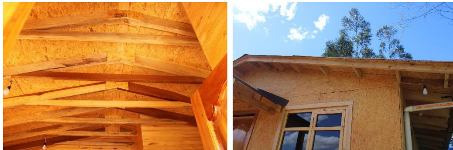
Fig. 50. Armadura de cubierta de madera
