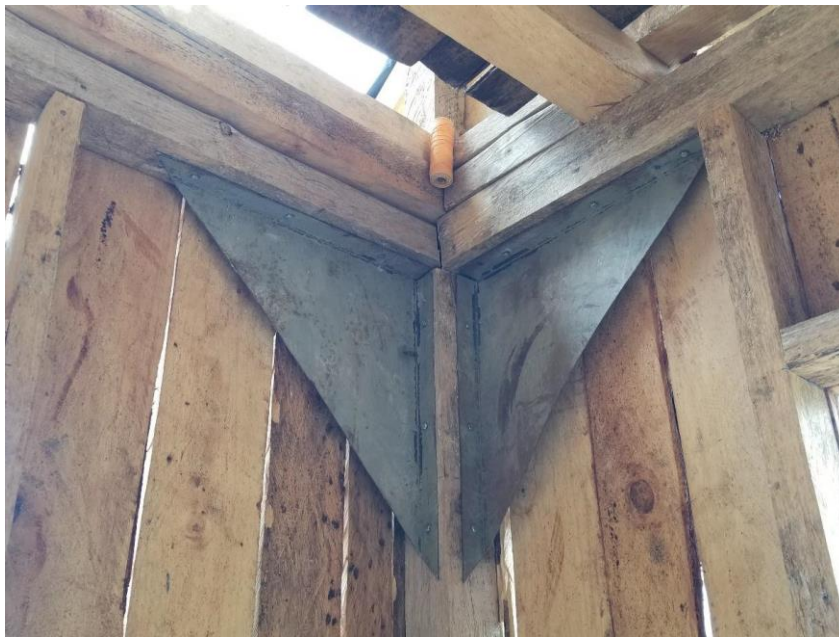
Fig. 84. Conexión con atiesador nudo 1-A
