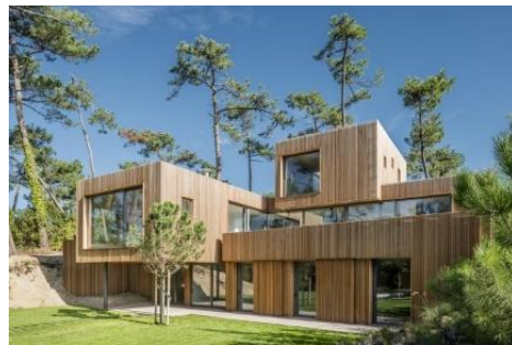
Fig. 8. Vivienda con madera prefabricada o laminada
