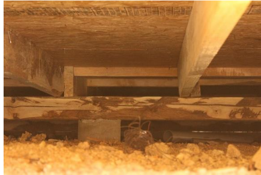
Fig. 60. Junta simple de vigas secundarias
