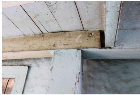
Fig. 57. Junta de empalme de espiga cuadrada
