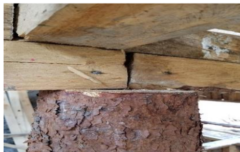
Fig. 64. Conexión con clavos
