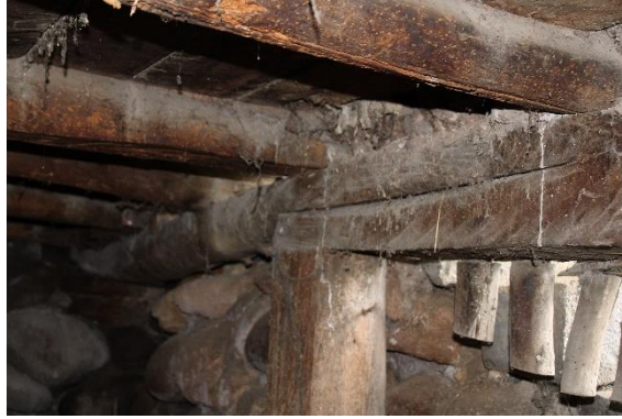
Fig. 55. Junta a media madera
