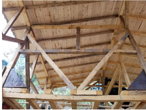
Fig. 67. Conexión con diagonales en marcos de madera.
