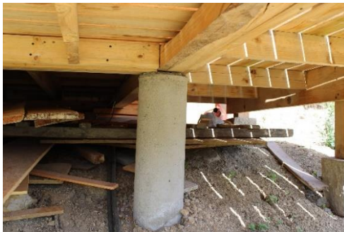
Fig. 59. Unión de vigas a cimientos
