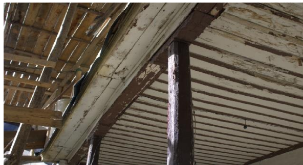
Fig. 54. Conexión tipo ensamble
