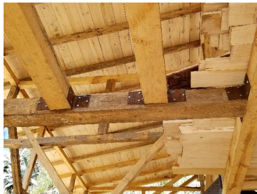
Fig. 66. Conexión con placa de acero y pernos
