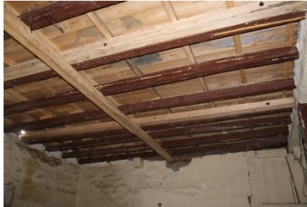
Fig. 45: Vigas de madera
