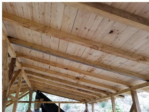
Fig. 68. Cubierta a dos aguas
