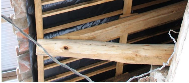
Fig. 58. Unión tipo ensamble de barbilla
