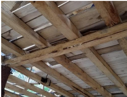
Fig. 52. Vigas principales y secundarias
