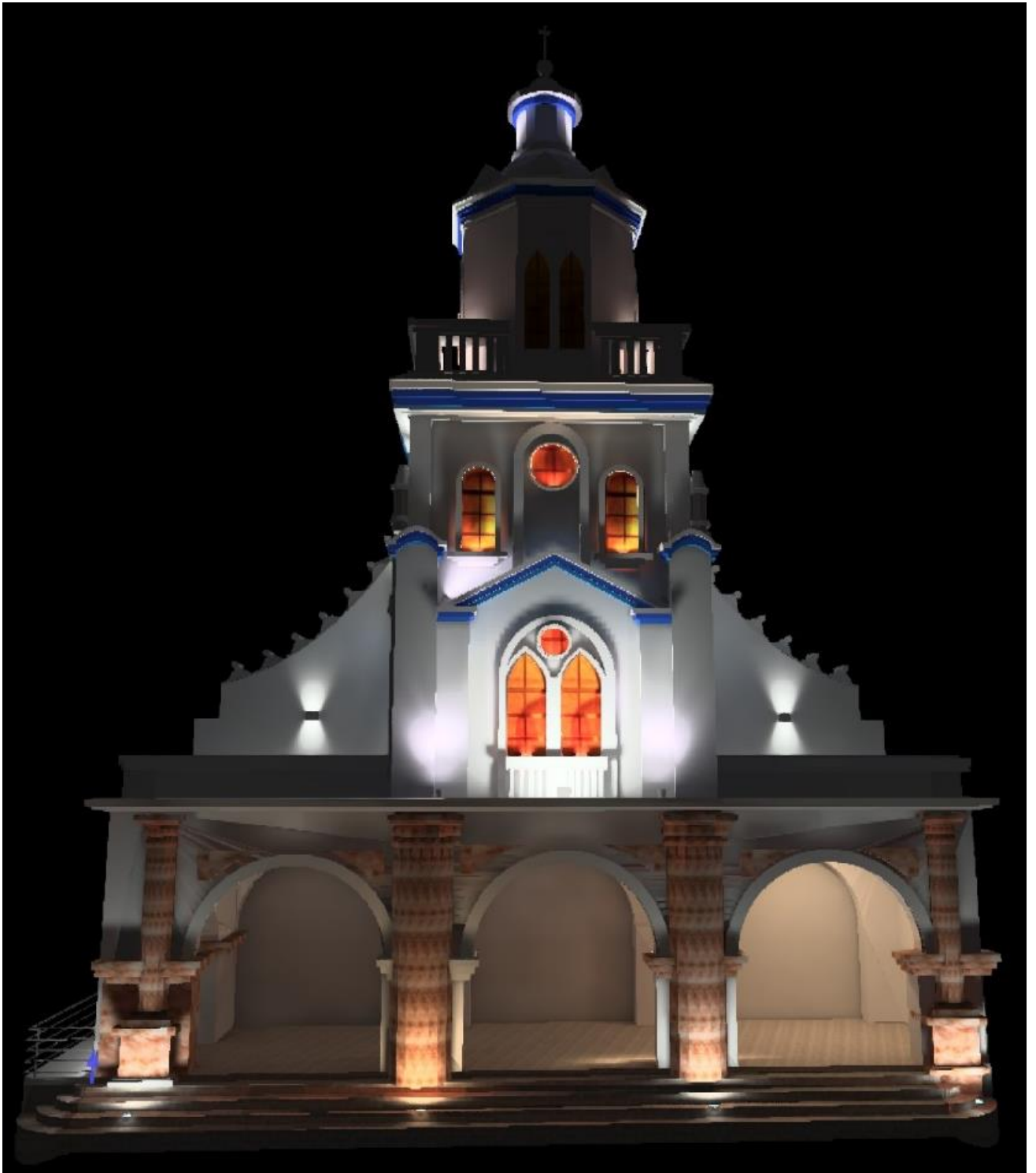
Fig. 5 Fachada Frontal actual
